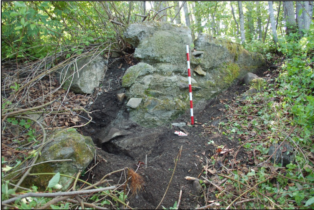
Photo 23 Structure de maçonnerie, secteur 6, au ch. 14+120, vers le sud-ouest (PATR11N02-117)
