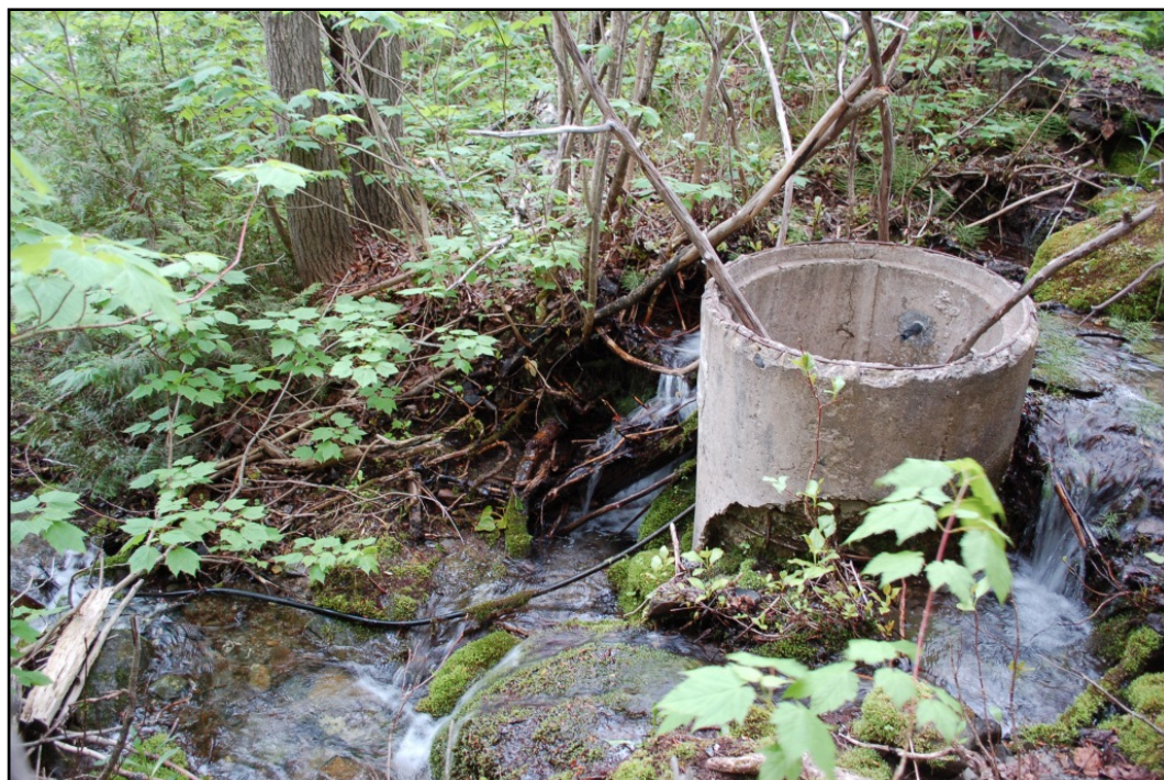
Photo 12 Ruisseau, secteur 4, installation artisanale d'un puits artésien, au ch. 163+200, vers le sud-est (PATR11N02-139)
