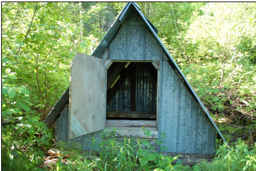
Photo 28 Puits artésien recouvert d'une toiture triangulaire en tôle, au ch. 14+950, vers le sud (PATR11N02-040)
