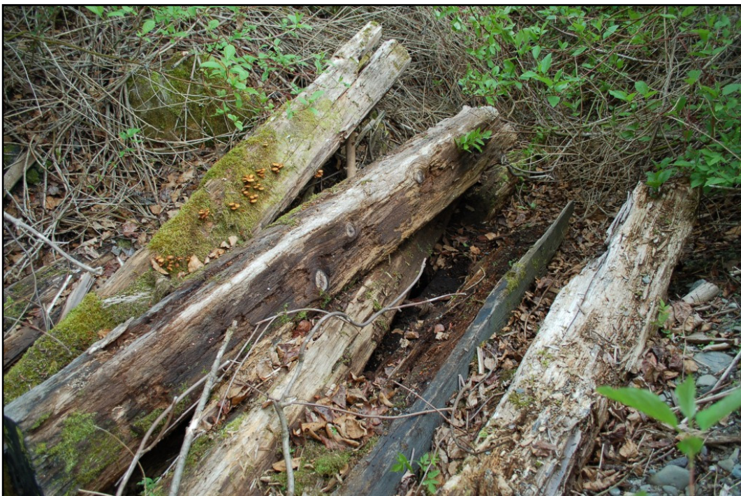
Photo 26 Amas de poutres carrées (hors emprise), situées à \pm 20 m de la structure de maçonnerie, à la hauteur du ch. 14+140, vers l'ouest (PATR11N02-132)
