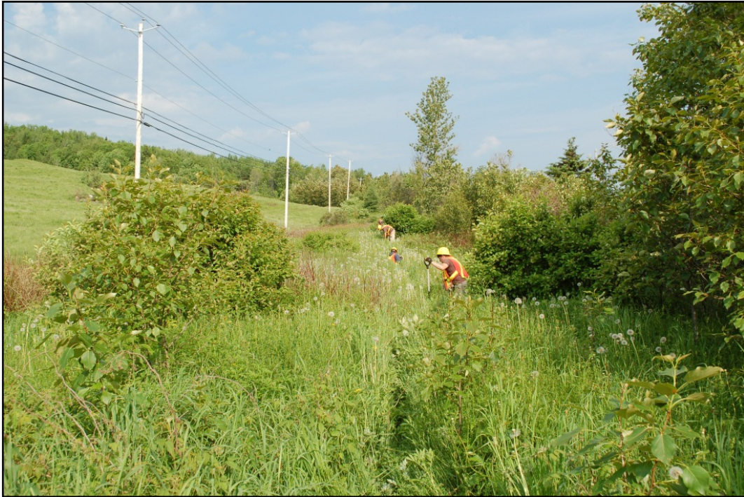
Photo 9 Vue du secteur 3, au ch. 12+520, vers le nord-ouest (PATR11N02-188)
