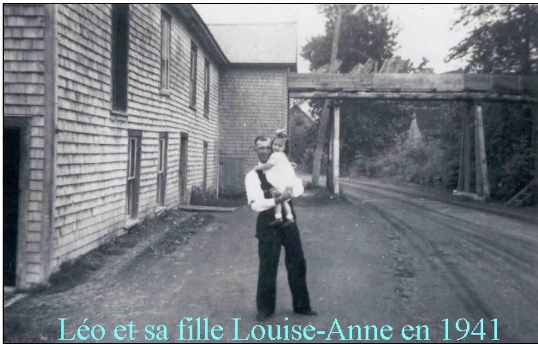
Figure 16 Le moulin à moudre, photo de 1941, vue vers le sud-est (source : Landry 2005)
