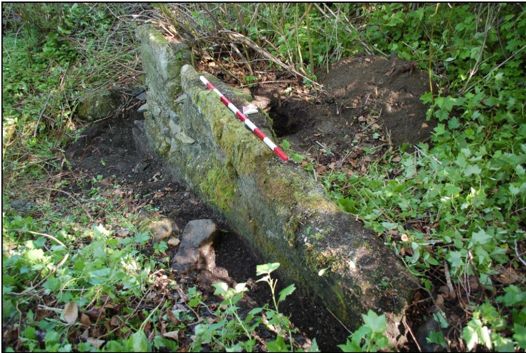
Photo 25 Vue du mur de maçonnerie (partie dégagée), secteur 6, au ch. 14+120, vers le sud-est (PATR11N02-122)
