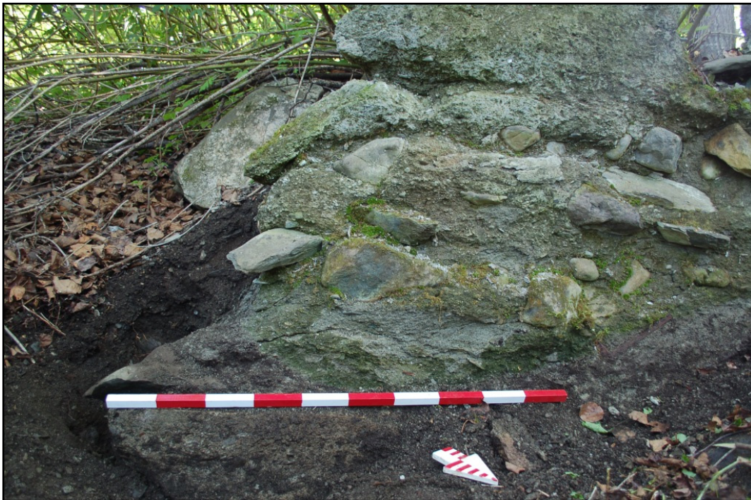
Photo 24 Vue de la base de la structure de maçonnerie, secteur 6, au ch. 14+120, vers le sud-ouest (PATR11N02-120)
