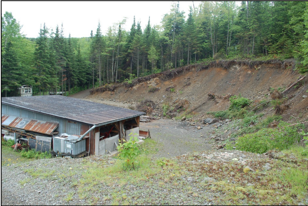
Photo 17 Banc de gravier, secteur 5, au ch. 13+900, vers le sud (PATR11N02-236)
