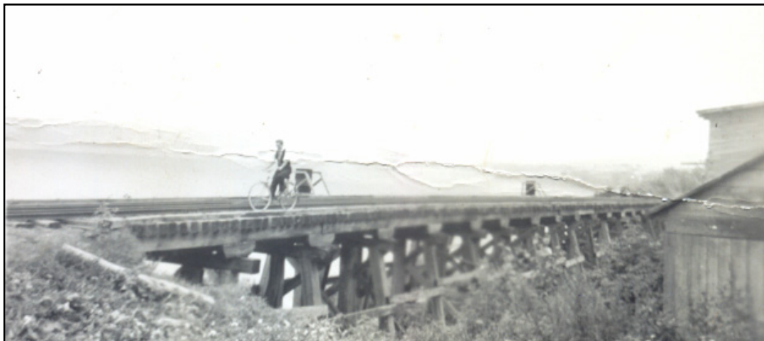
Figure 17 Le « trestle » (pont sur chevalet de bois du chemin de fer) qui permettait de franchir la rivière Creuse. Le coin nord-ouest du moulin apparaît en bas, à droite de la photo. Photo prise avant 1948. Vue vers le sud-est (source : Landry, 2005)
