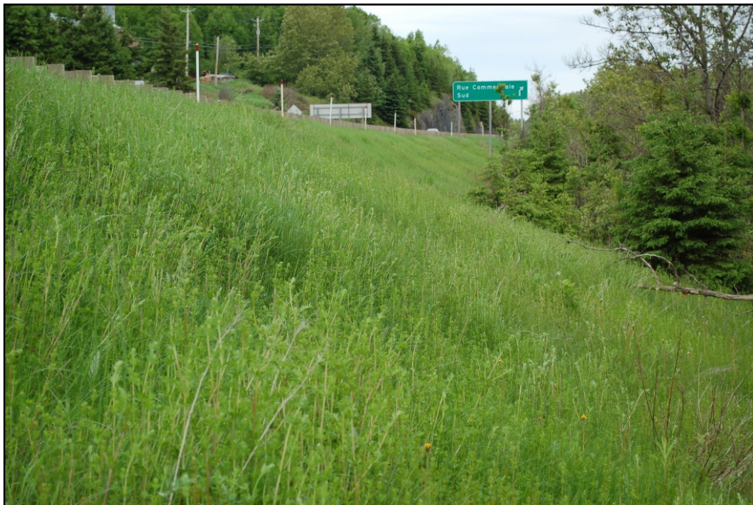
Photo 11 Vue du secteur 4, remblai, au ch. 163-060, vers le nord-ouest (PATR11N02-141)
