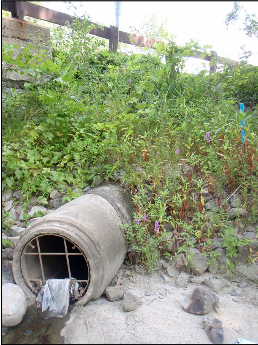
Photo 5 : Pente, remblai de pierre et tuyau d'égout pluvial, secteur 4, direction nord-est (154-94-0773-10-NUM1-1)
