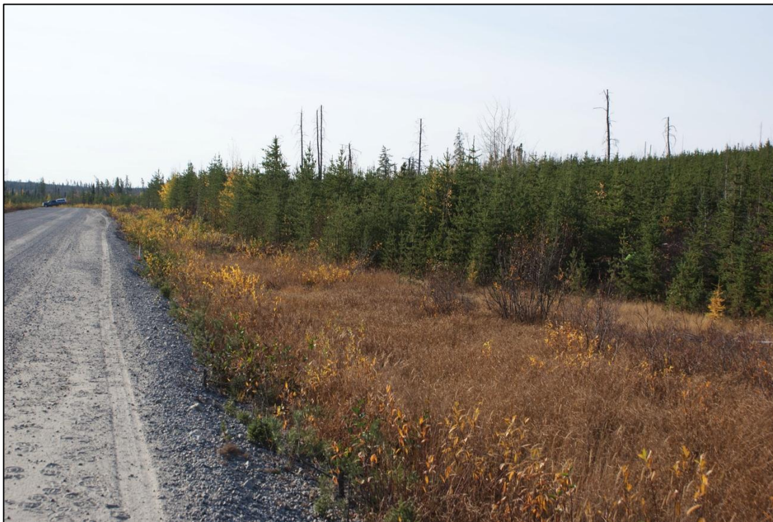
Photo 13 Secteur 2-1, chaînage 37+440, vue panoramique, direction sud
