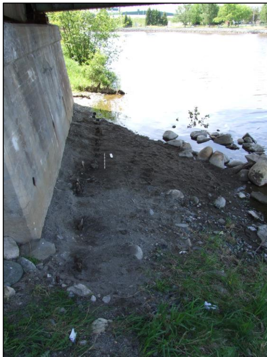
Photo 1 Secteur nord-est et sud-est, vue générale de l'ensemble des pieux et des caissons direction sud
