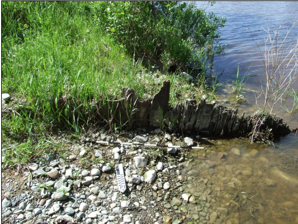
Photo 3 Secteur sud-est, muret ou portion d'un caisson n°1, direction sud
