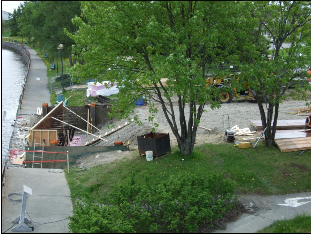
Photo 7 Secteur sud-ouest, plan rapproché sur le coffrage de la culée du pont temporaire, direction sud
