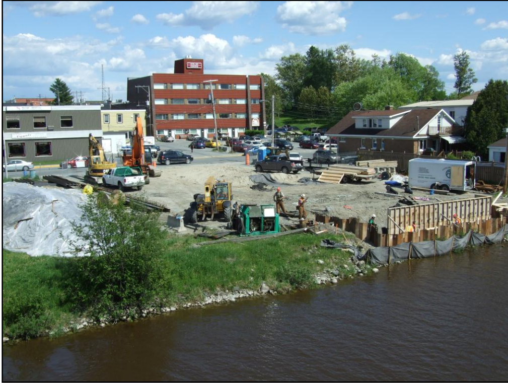
Photo 5 Secteur sud-est, état des lieux, direction sud-est
