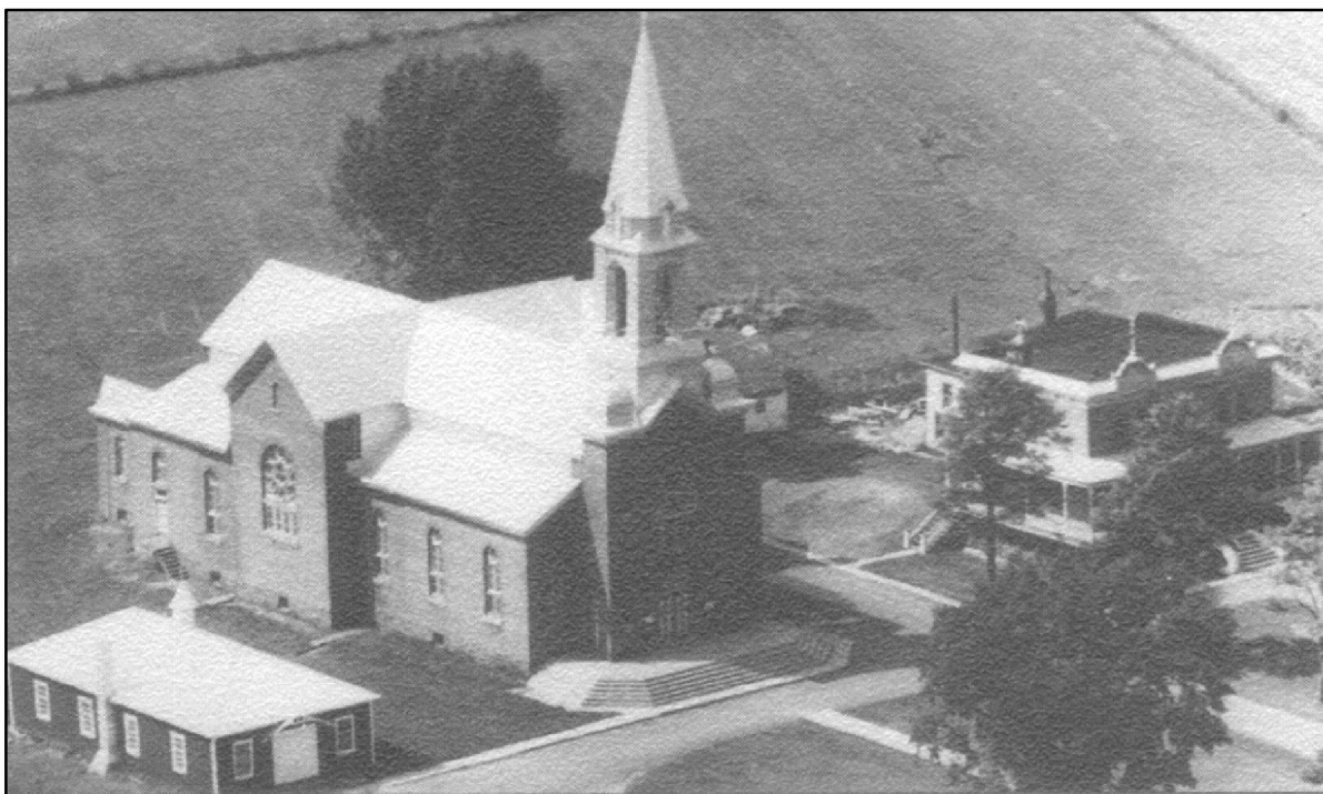
Figure 11 Vue aérienne de l'église, du presbytère et de la station de pompe (tiré de l'album souvenir Saint-Marcel-de-Richelieu 1852-2002 )
