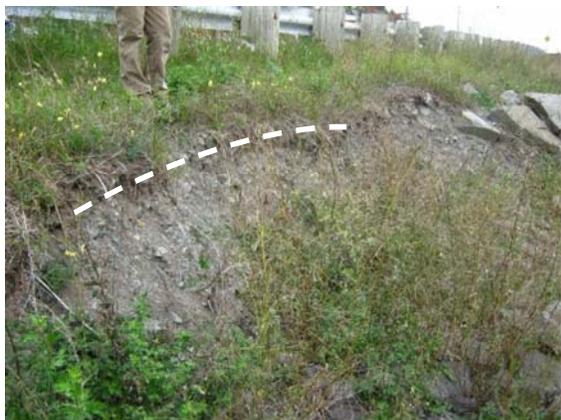
**Photo 3.5** Encoche d'érosion entre la glissière de sécurité de la route et le haut de l'enrochement
