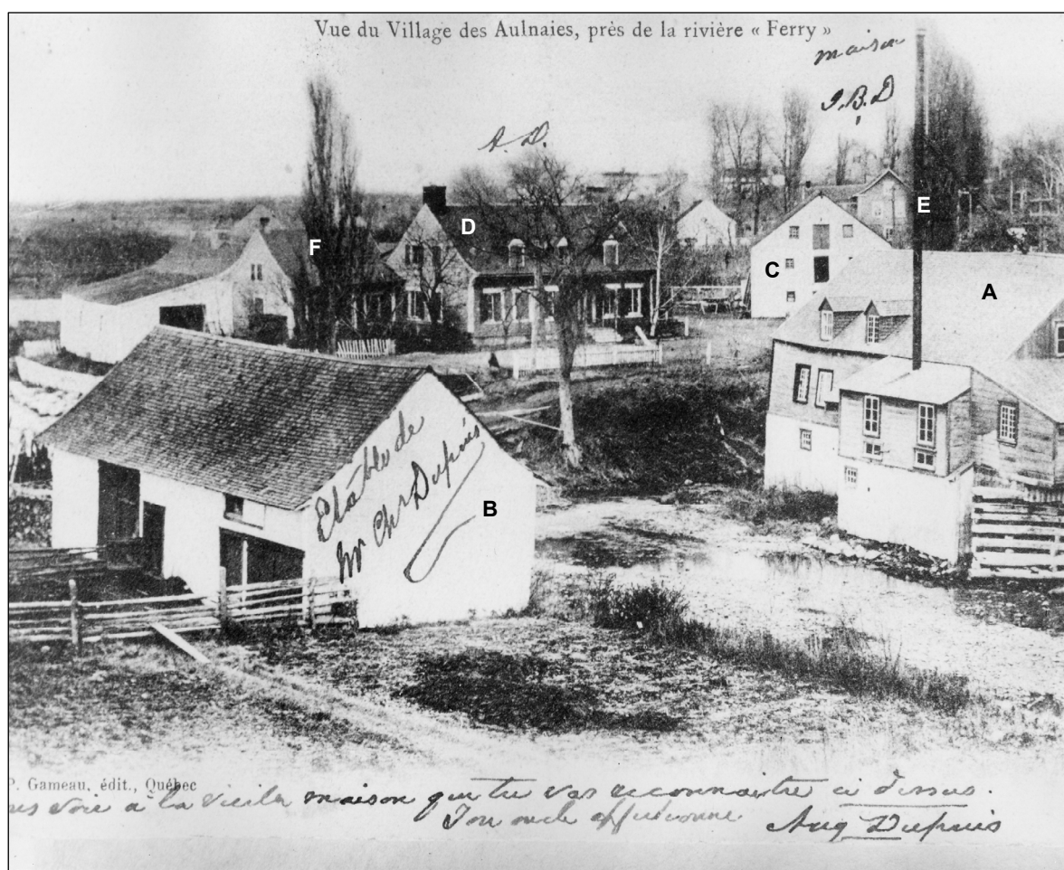
Figure 21 : Bâtiments à proximité de la rivière Ferrée.
