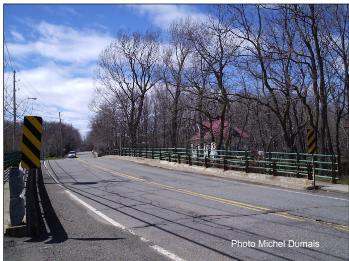
Photo 20 : Vue du pont Deschênes, direction ouest
