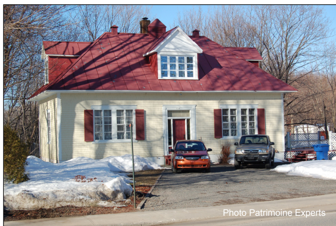
Photo 17 : Résidence du n o civique 530, route de la Seigneurie (route 132), direction nord
