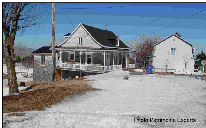
Photo 14 : Résidence n° civique 1054, route de la Seigneurie (route 132), direction nord-est
