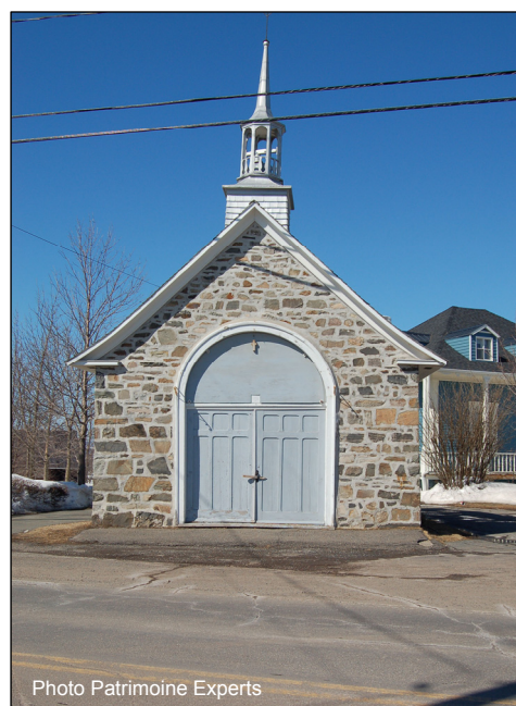
Photo 25 : Partie de la zone E-8 : terrain autour de la chapelle de procession (côté nord de la route de la Seigneurie (route 132)), direction nord
