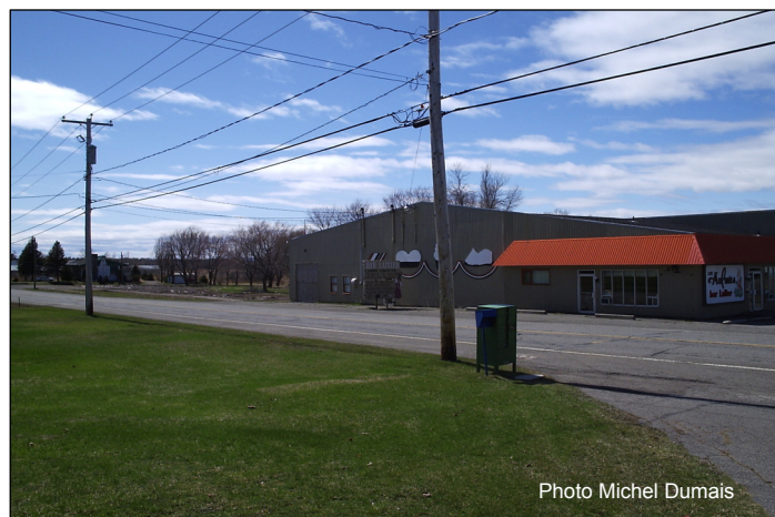
Photo 31 : Partie de la zone E-10 : une partie des vestiges des industries Wilsons pourrait se retrouver dans l'emprise à l'ouest du local du bar laitier (côté nord de la route de la Seigneurie (route 132)), direction nord-ouest
