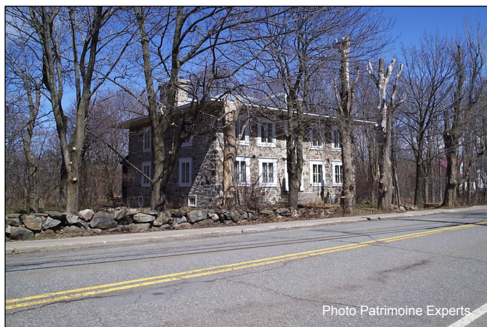
Photo 37 : Partie de la zone E-16 : maison de Pierre Miville Deschênes (côté nord de la route de la Seigneurie (route 132)), direction nord-est
