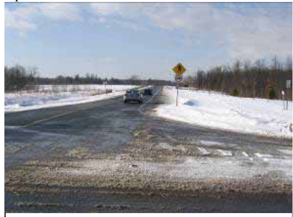
Planche 91 - Vue vers l'ouest le long de l'emprise de la voie de service nord. Un potentiel existe au-delà de l'emprise perturbée.
