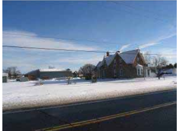
Planche 14 - Vue vers le nord, au 901, chemin March.
