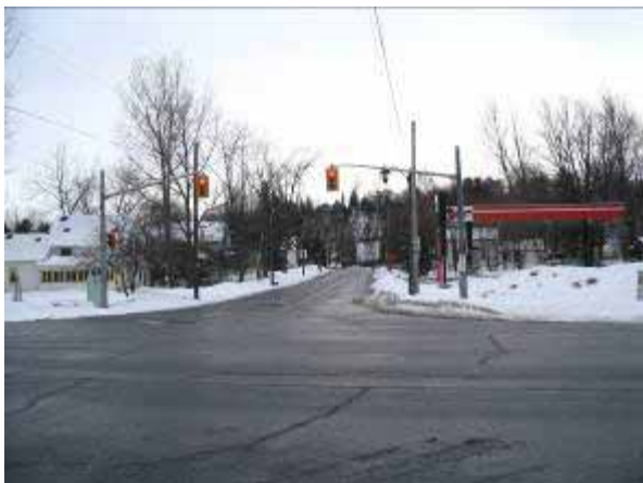
Planche 108 - Vue vers le sud-sud-est le long du chemin Cameron, à partir de l'autoroute 174.
