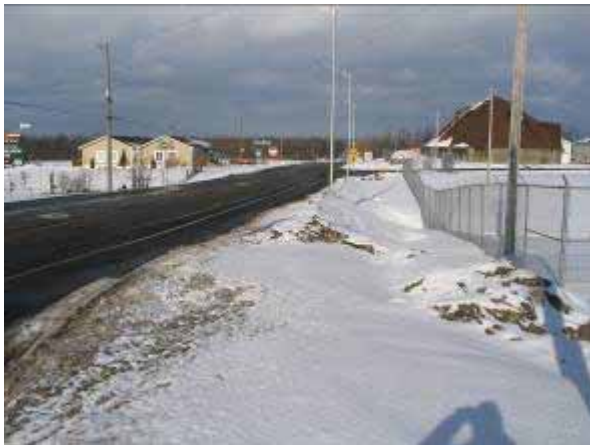
Planche 90 - Vue vers le nord-nord-ouest le long du chemin Trim. L'emprise a été perturbée par les activités antérieures de construction.
