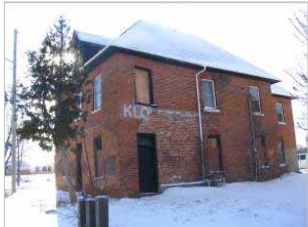
Planche 10 - Vue vers le sud-ouest; le Klondike Inn
