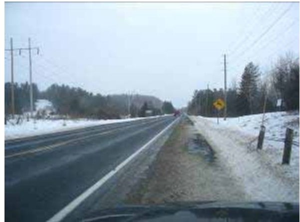
Planche 101 - Vue vers l'ouest le long de l'autoroute 174. Noter la pente du côté nord de la route.
