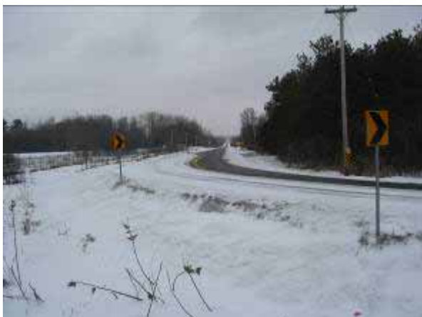
Planche 29 - Vue vers le sud-ouest le long du chemin Riddell, montrant l'emprise surélevée.
