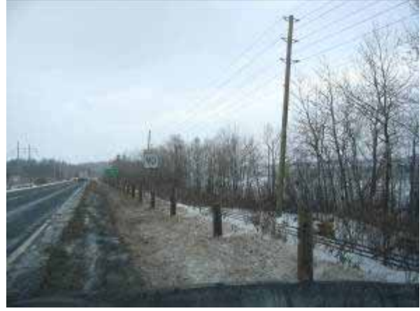
Planche 103 - Vue vers l'ouest-nord-ouest le long de l'autoroute 174. Noter l'emprise perturbée.
