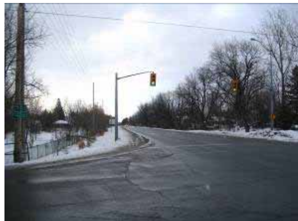
Planche 109 - Vue vers l'est-nord-est le long de l'autoroute 174, à partir du chemin Cameron.
