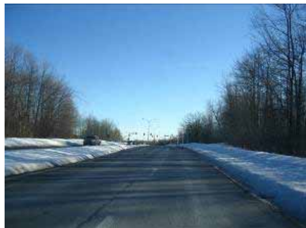
Planche 52 - Vue vers le sud-est le long de la promenade de l'Aviation, vers le chemin Ogilvie.
