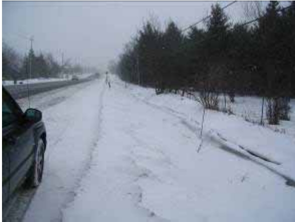
Planche 19 - Vue vers le sud-ouest, du chemin March, vers un secteur mal drainé. Noter la pente à partir du lit de la route.
