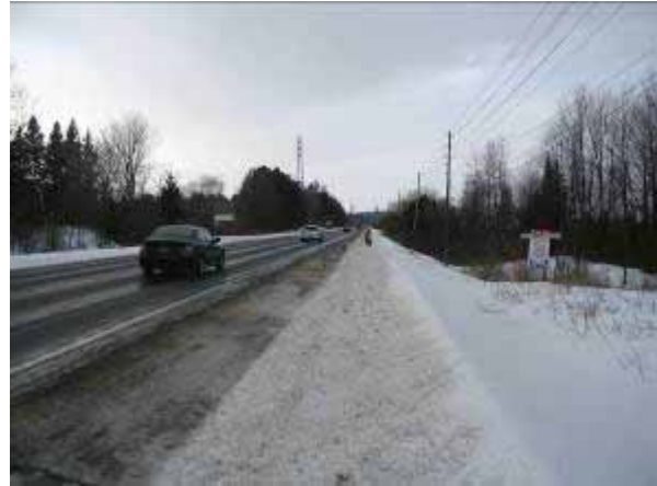
Planche 105 - Vue vers l'ouest le long de l'autoroute 174 en direction d'un passage de cours d'eau.
