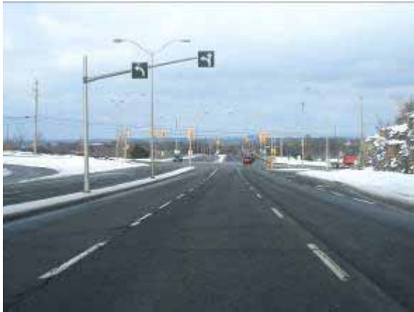
Planche 78 - Vue vers le nord-nord-ouest le long de la 10 th Line en direction de l'autoroute 174. L'emprise a été antérieurement perturbée.
