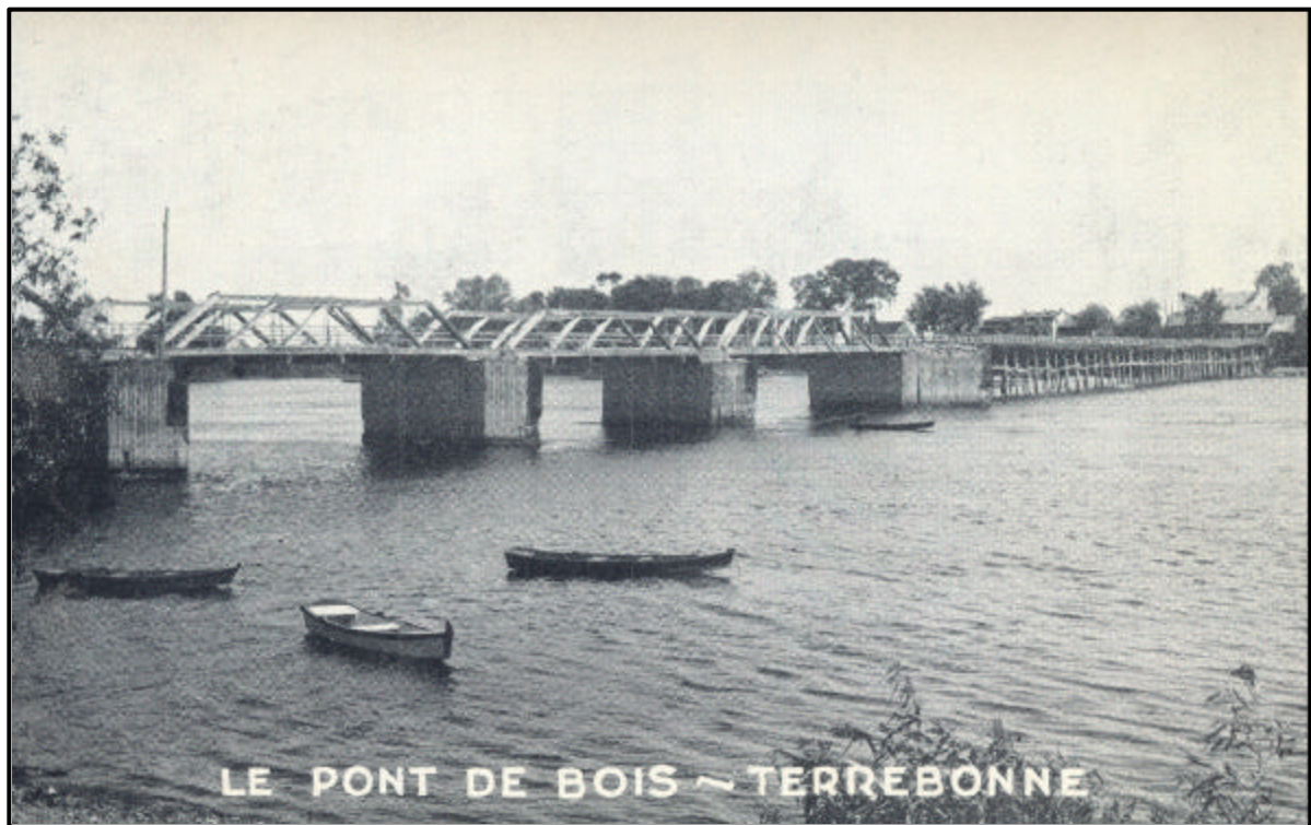
Figure 5 : Pont de bois, avant 1907 (Gareau 1927)
