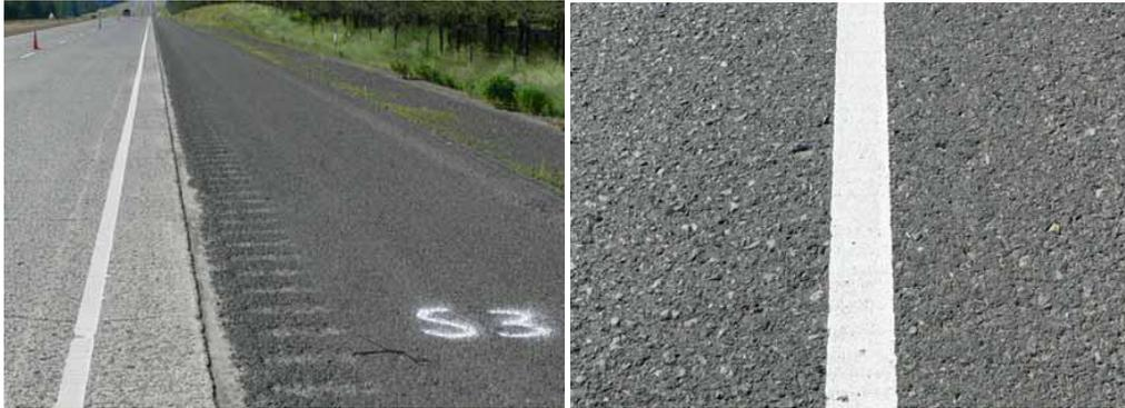
**Photo 4 - Photos du MMA appliqué sur du béton (à gauche) et du bitume (à droite) après la deuxième période de maintenance hivernale**
