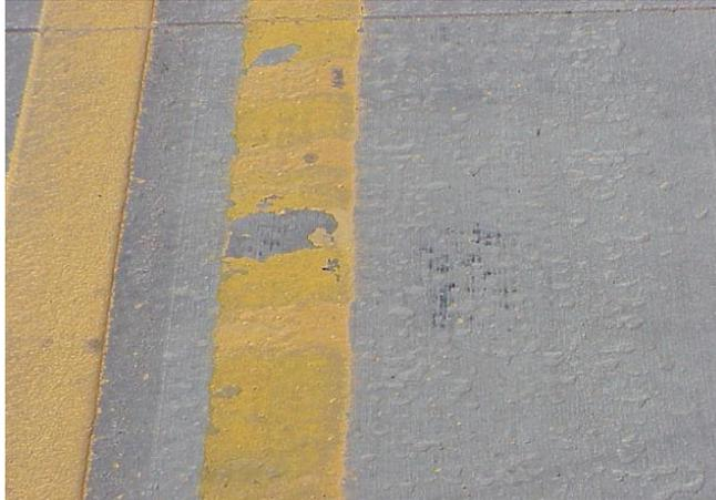
**Photo 7 - époxy en rainure à gauche, en surface à droite**
