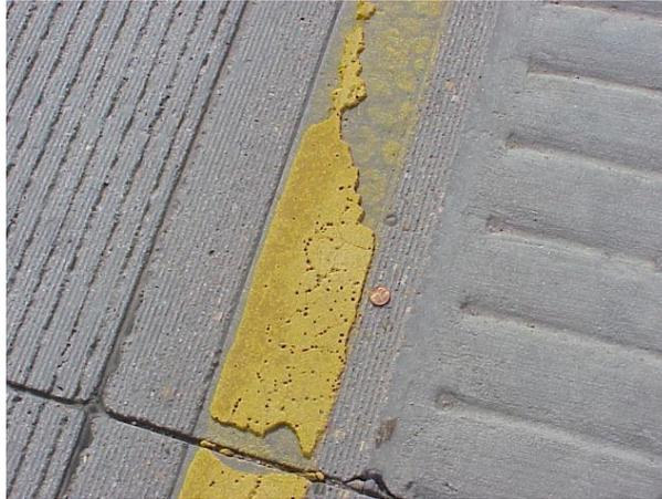
**Photo 5 - Manque d'adhésion du thermoplastique sur le béton**
