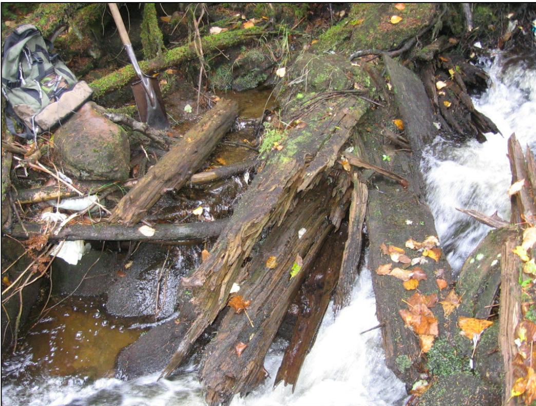
Photo 33 : Ch. 281+280, ouvrage de bois et de moellons effondré (pont ?), direction sud (photo n° 154-99-0665-206)
