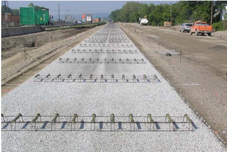
Figure 2.7 : Goujons sur paniers avant bétonnage [Turgeon et al., 2009]
