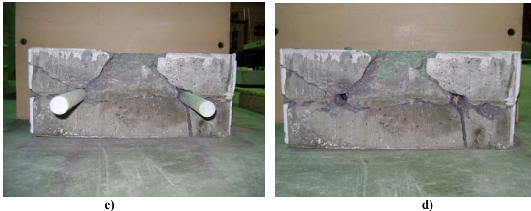
Figures 3.94 : Réseau de fissure à la rupture après 1 million de cycles (dalle PRFV 34,9 mm)
