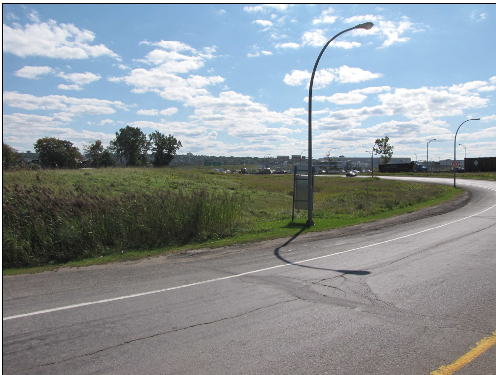
Photo 22 : Projet n° 154-97-0478, secteur 10, vue générale de l'emprise, ville de Québec, direction sud-est (photo n° 154-97-0478-109)
