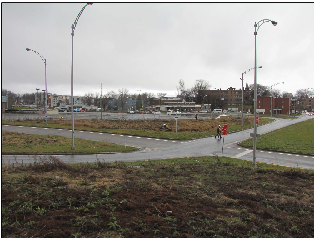
Photo 4 : Projet n° 154-03-0556, secteur 3, vue générale de l'emprise, chaînage 0+150, communauté urbaine de Québec, direction sud (photo n° 154-03-0556-6)
