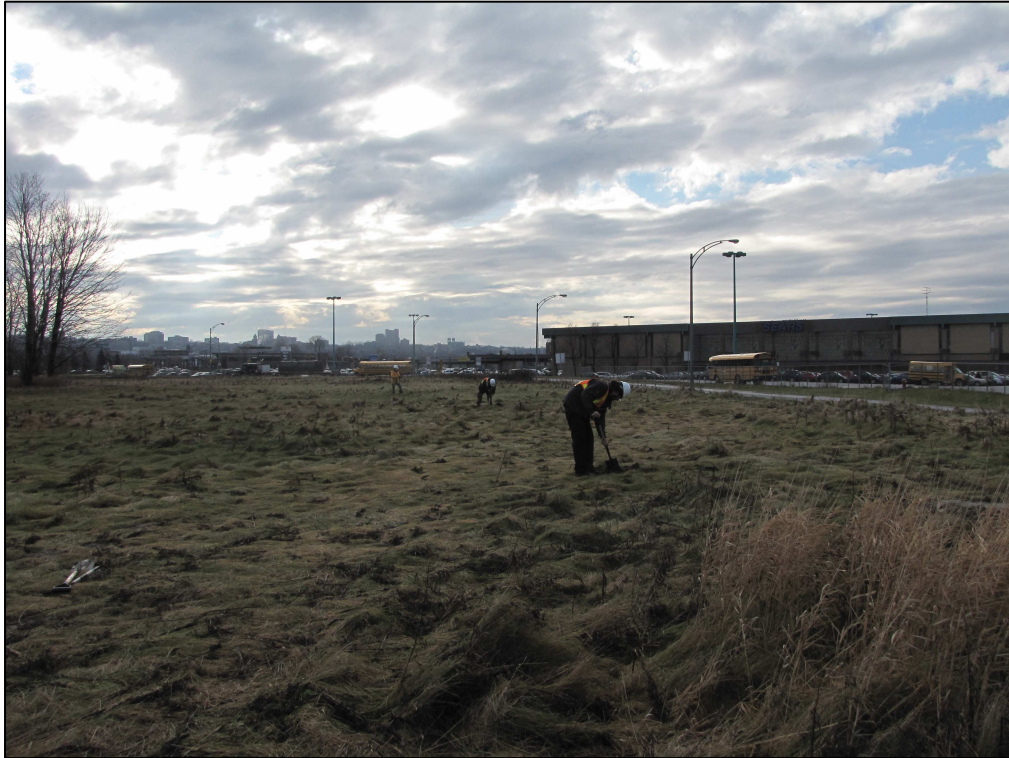
Photo 9 : Projet n° 154-03-0556, secteur 10, vue générale de l'emprise, chaînage 0+390, communauté urbaine de Québec, direction ouest (photo n° 154-03-0556-24)
