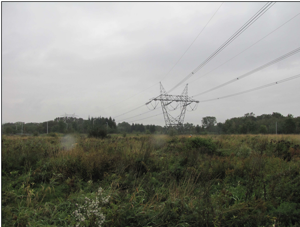
Photo 18 : Projet n° 154-97-0478, sous-secteur 7a, vue générale de l'emprise, ville de Québec, direction est (photo n° 154-97-0478-126)
