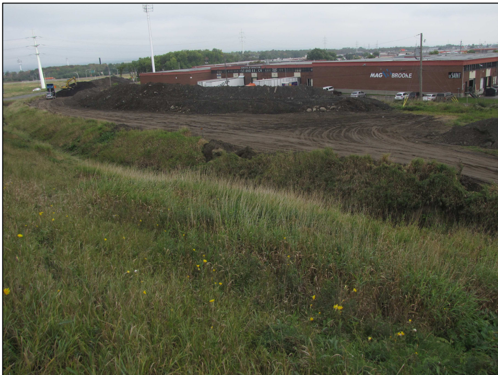
Photo 27 : Projet n° 154-97-0478, secteur 17, vue générale de l'emprise de la portion sud, où les travaux avaient débuté, ville de Québec, direction nord-est (photo n° 154-97-0478-158)
