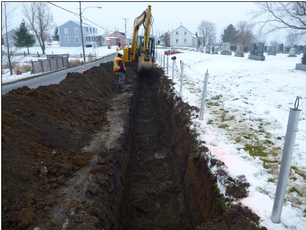
Photo 8 : Projet n° 154-06-0225, vue générale de 1C en cours d'excavation, chaînage 4+118, rang Bois-Franc Ouest, municipalité de Notre-Dame-du-Sacré-Cœur-d'Issoudun, direction sud-ouest (photo n° 154-06-0225-48)
