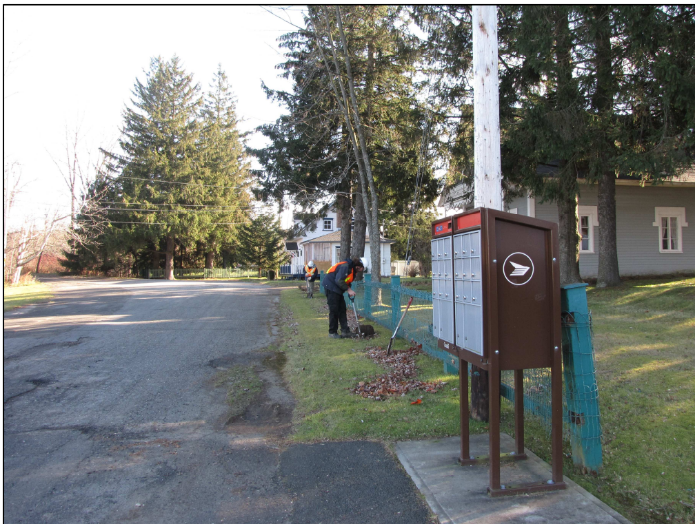
Photo 16 : Projet n° 154-08-0376, vue générale de l'emprise, chaînage 1+525, côté sud de la rue du Moulin, municipalité de Leclercville, direction sud-ouest (photo n° 154-08-0376-38)
