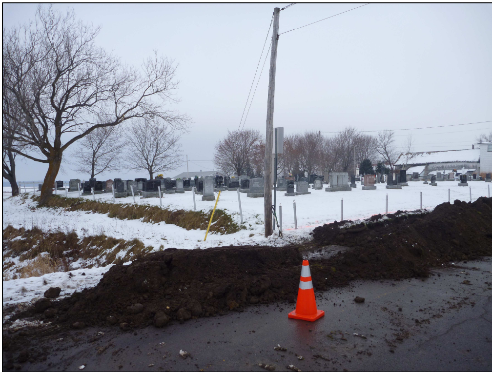
Photo 2 : Projet n° 154-06-0225, vue du côté ouest du cimetière, chaînage 4+070, rang Bois-Franc Ouest, municipalité de Notre-Dame-du-Sacré-Cœur-d'Issoudun, direction nord (photo n° 154-06-0225-42)
