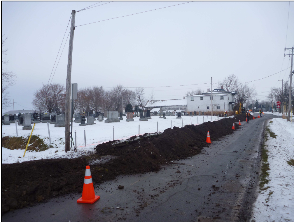
Photo 1 : Projet n° 154-06-0225, vue générale de l'emprise, chaînage 4+070, rang Bois-Franc Ouest, municipalité de Notre-Dame-du-Sacré-Cœur-d'Issoudun, direction nord-nord-est (photo n° 154-06-225-41)
