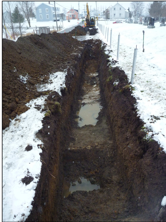
Photo 3 : Projet n° 154-06-0225, vue générale de 1A après excavation, chaînage 4+130, rang Bois-Franc Ouest, municipalité de Notre-Dame-du-Sacré-Cœur-d'Issoudun, direction sud-ouest (photo n° 154-06-0225-17)
