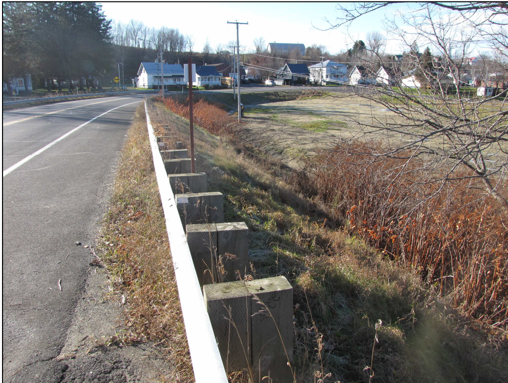
Photo 15 : Projet n° 154-08-0376, vue générale de l'emprise, chaînage 1+600, côté ouest de la route 132, municipalité de Leclercville, direction sud-ouest (photo n° 154-08-0376-58)
