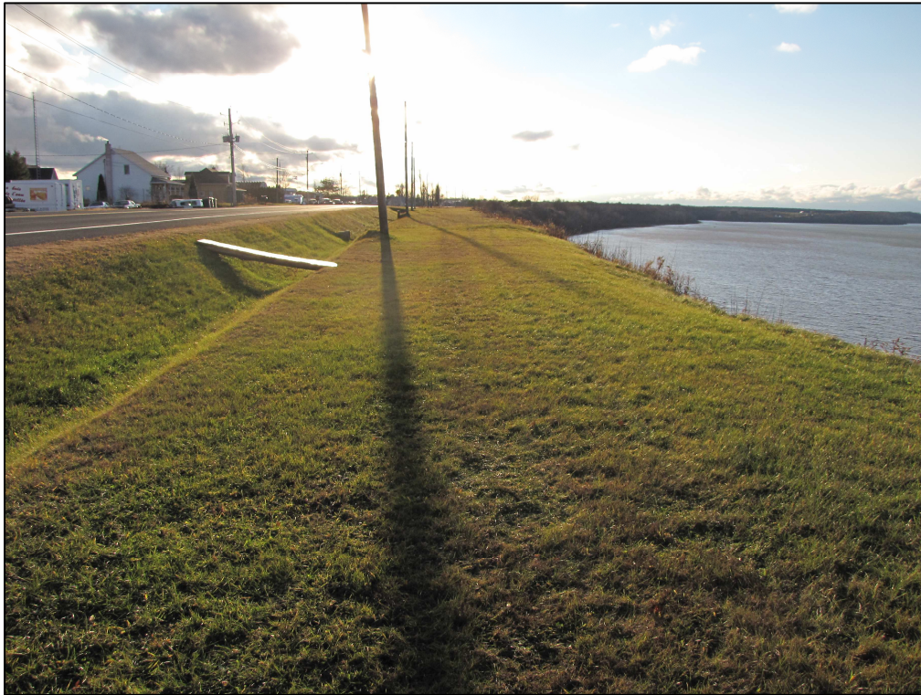
Photo 9 : Projet n° 154-08-0376, vue générale de l'emprise, chaînage 0+250, côté nord de la route 132, municipalité de Leclercville, direction sud-ouest (photo n° 154-08-0376-6)
