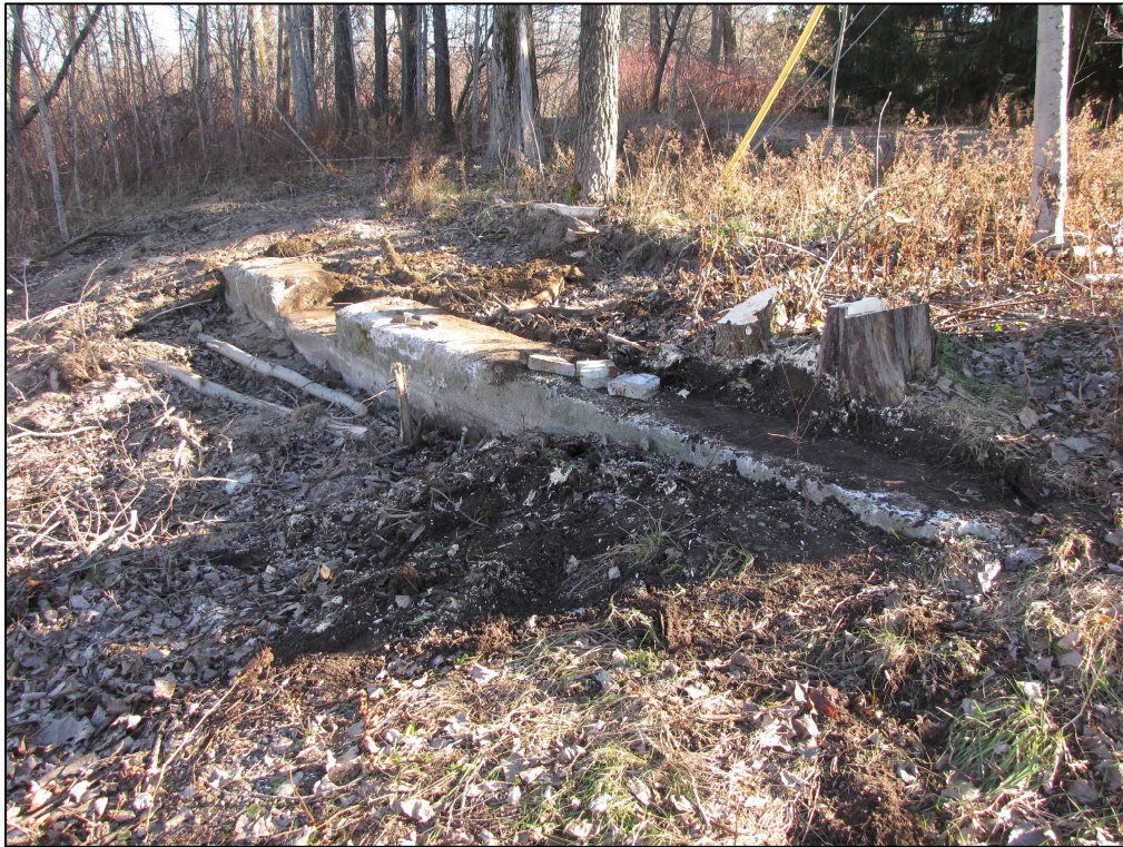
Photo 17 : Projet n° 154-08-0376, vestige en béton entre la route 132 et la rue du Moulin, municipalité de Leclercville, direction nord-est (photo n° 154-08-0376-40)
