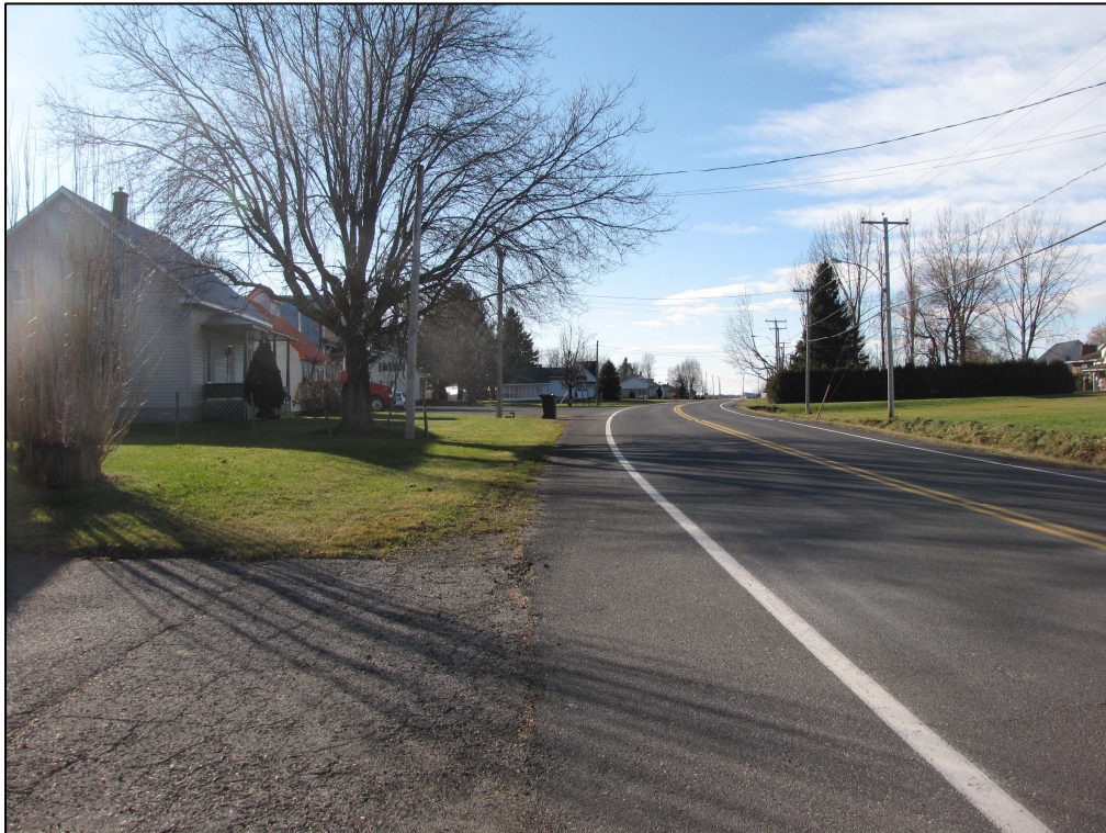
Photo 11 : Projet n° 154-08-0376, vue générale de l'emprise, chaînage 0+870, côté sud de la route 132, municipalité de Leclercville, direction ouest (photo n° 154-08-0376-68)
