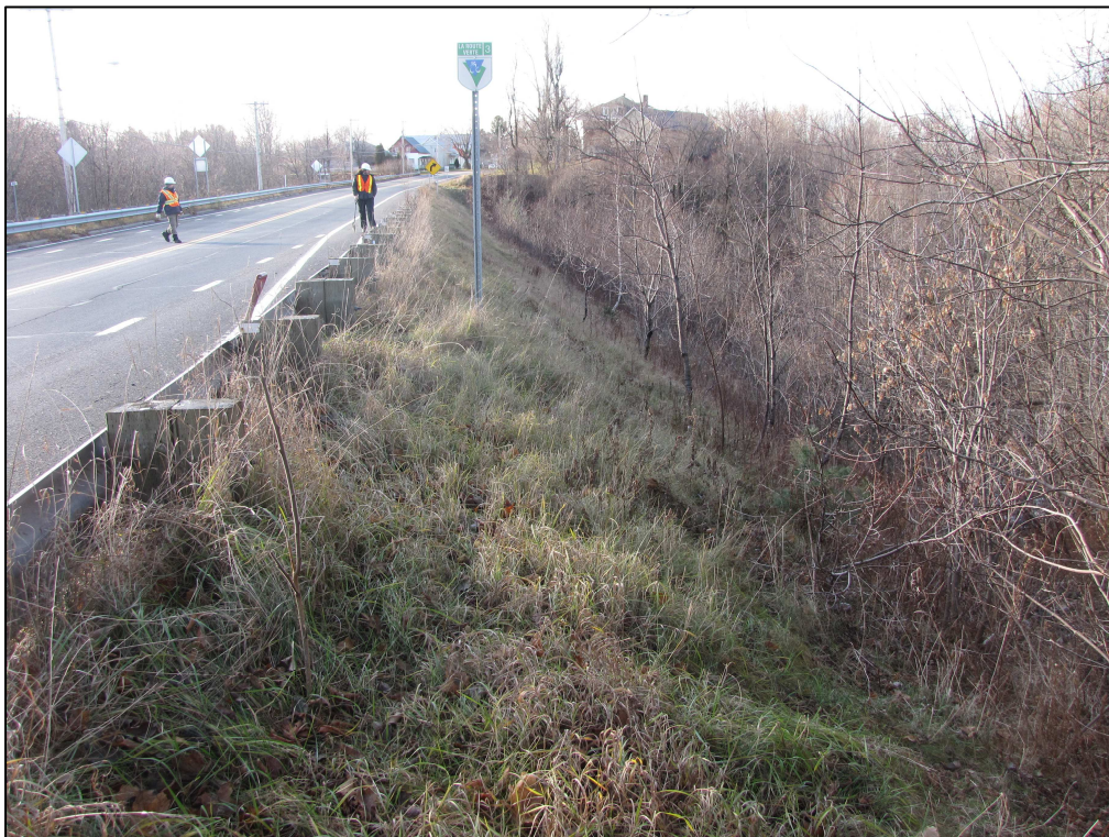
Photo 12 : Projet n° 154-08-0376, vue générale de l'emprise, chaînage 1+050, côté nord de la route 132, municipalité de Leclercville, direction ouest (photo n° 154-08-0376-21)
