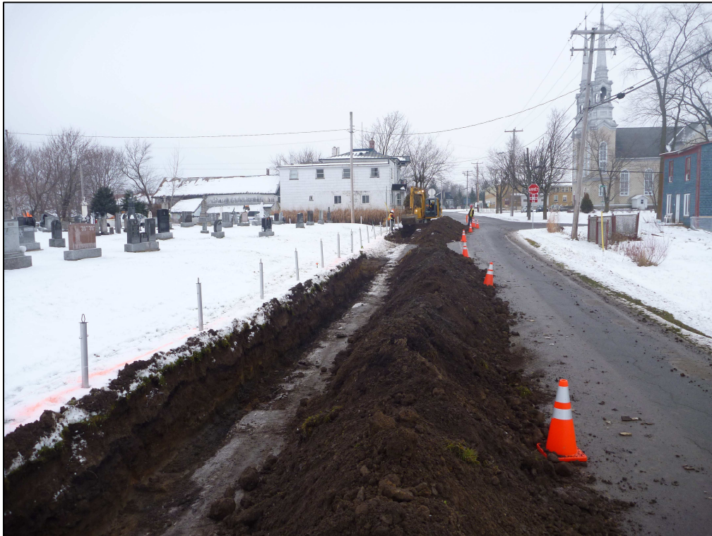
Photo 7 : Projet n° 154-06-0225, vue générale de 1B après excavation, chaînage 4+080, rang Bois-Franc Ouest, municipalité de Notre-Dame-du-Sacré-Cœur-d'Issoudun, direction nord-est (photo n° 154-06-0225-44)
