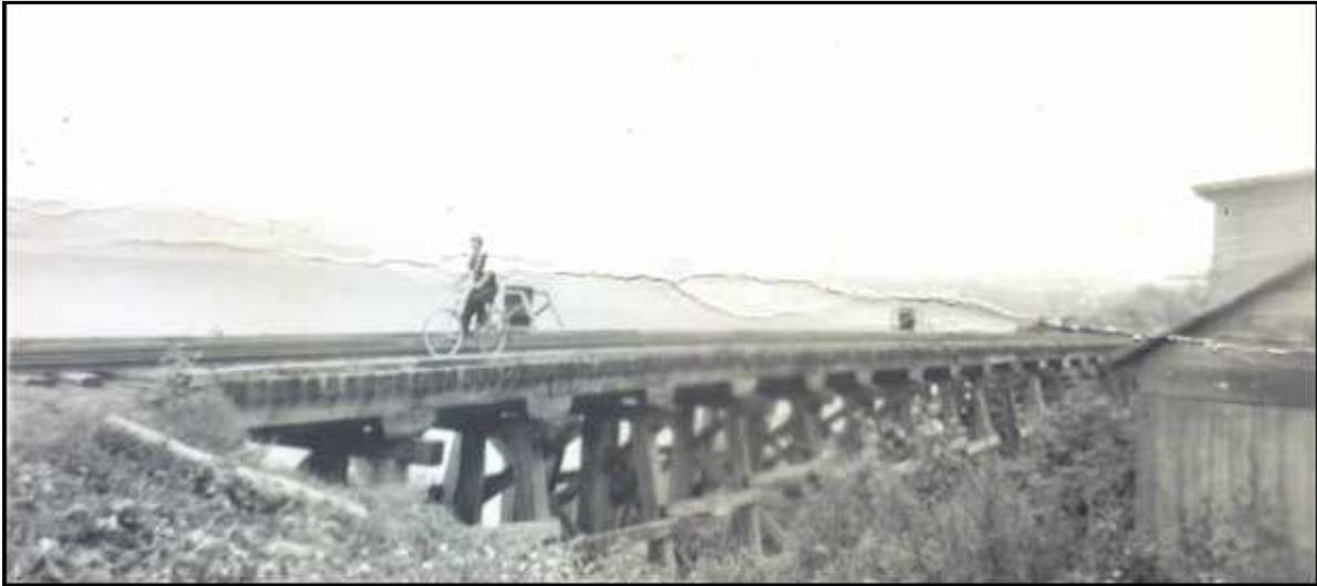
Figure 10 : Le « trestle » (pont sur chevalet de bois du chemin de fer) qui permettait d'enjamber la rivière Creuse. Photo prise avant 1948. Vue vers le sud-est (source : Landry, 2005), dans Patrimoine Experts, à paraître : 48.
