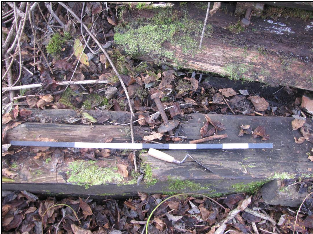
Photo 18 : Crampon avec rondelle bombée fiché dans une pièce de bois, portion sud, direction ouest (photo n° 154-02-2013-007).
