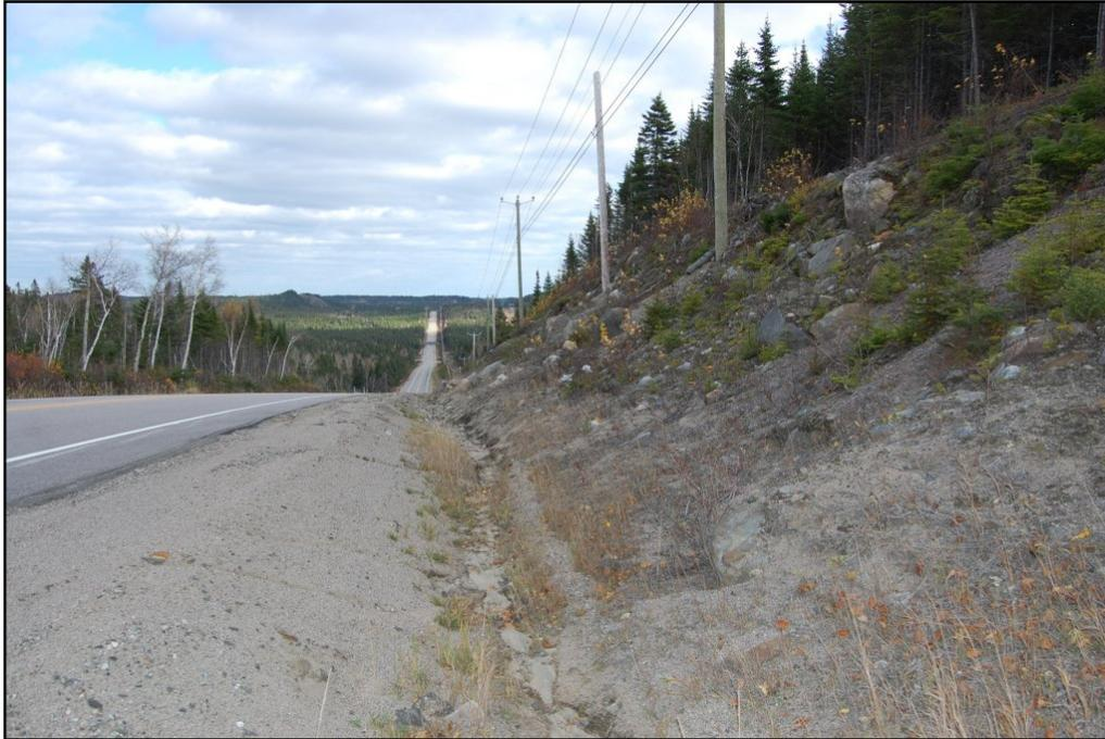
**Photo 18** Projet n° 154-00-0429, secteur 2, vue de l'emprise au ch. 14+900, surface coupée et remblayée en marge de la chaussée, direction est (PATR10N10-070)
