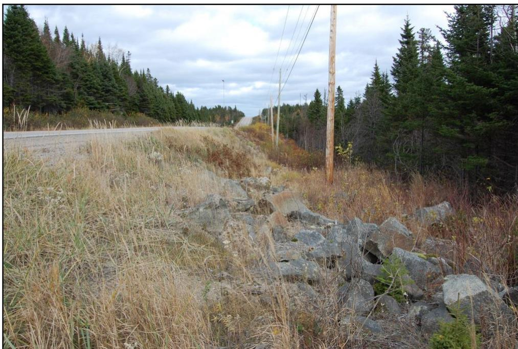
**Photo 16** Projet n° 154-00-0429, secteur 1, vue de l'emprise au ch. 12+850, blocs rapportés et remblais en marge de la chaussée, direction nord-est (PATR10N10-064)
