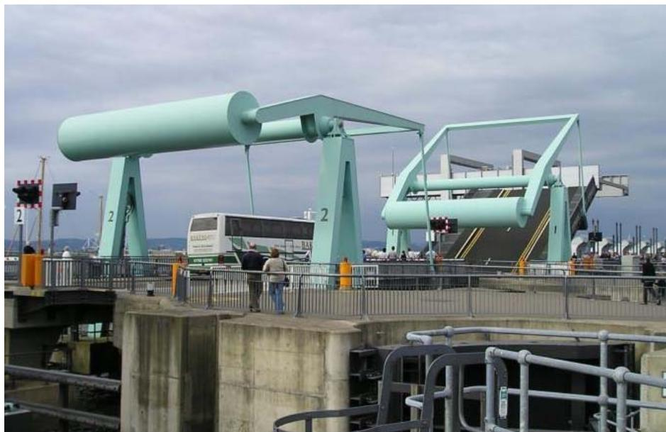
Figure 9 – Type de pont retenu pour le pont 9 du canal de Chambly [réf. : Ponts à bascule des écluses de Cardiff, Pays de Galles]
