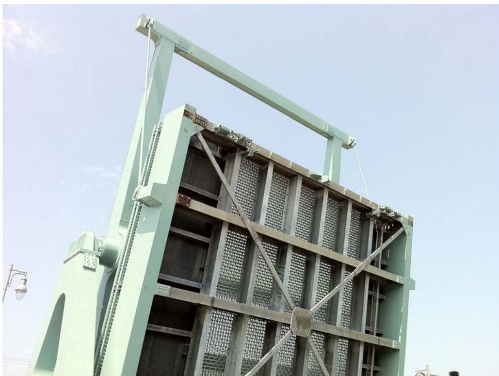
*Figure 38 – Dispositifs de sécurité à l'extrémité mobile du tablier*
