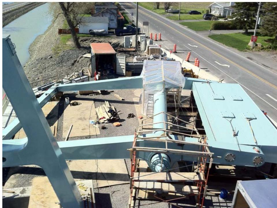
*Figure 32 – Assemblage au sol des éléments supérieurs*
