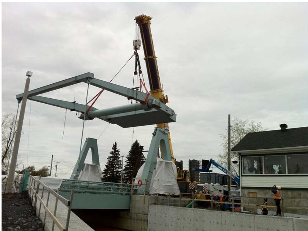
*Figure 33 – Levage et mise en place des éléments supérieurs (suite)*
