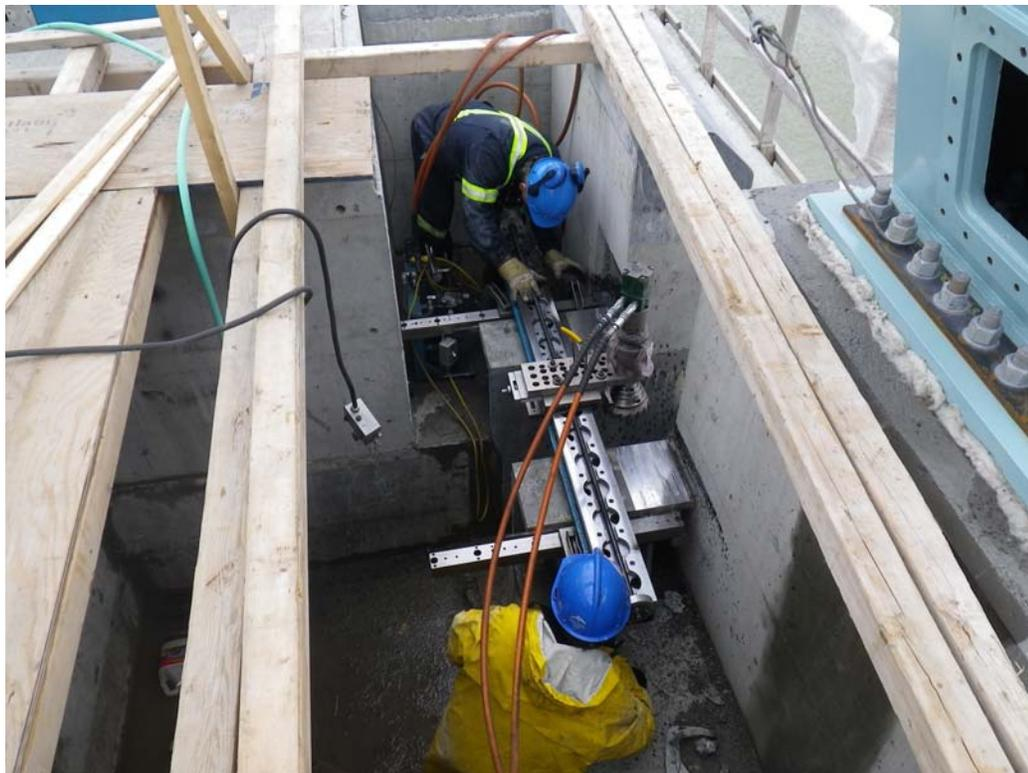
*Figure 30 – Usinage sur place des plateaux des pièces encastrées recevant les pivots inférieurs du tablier*
