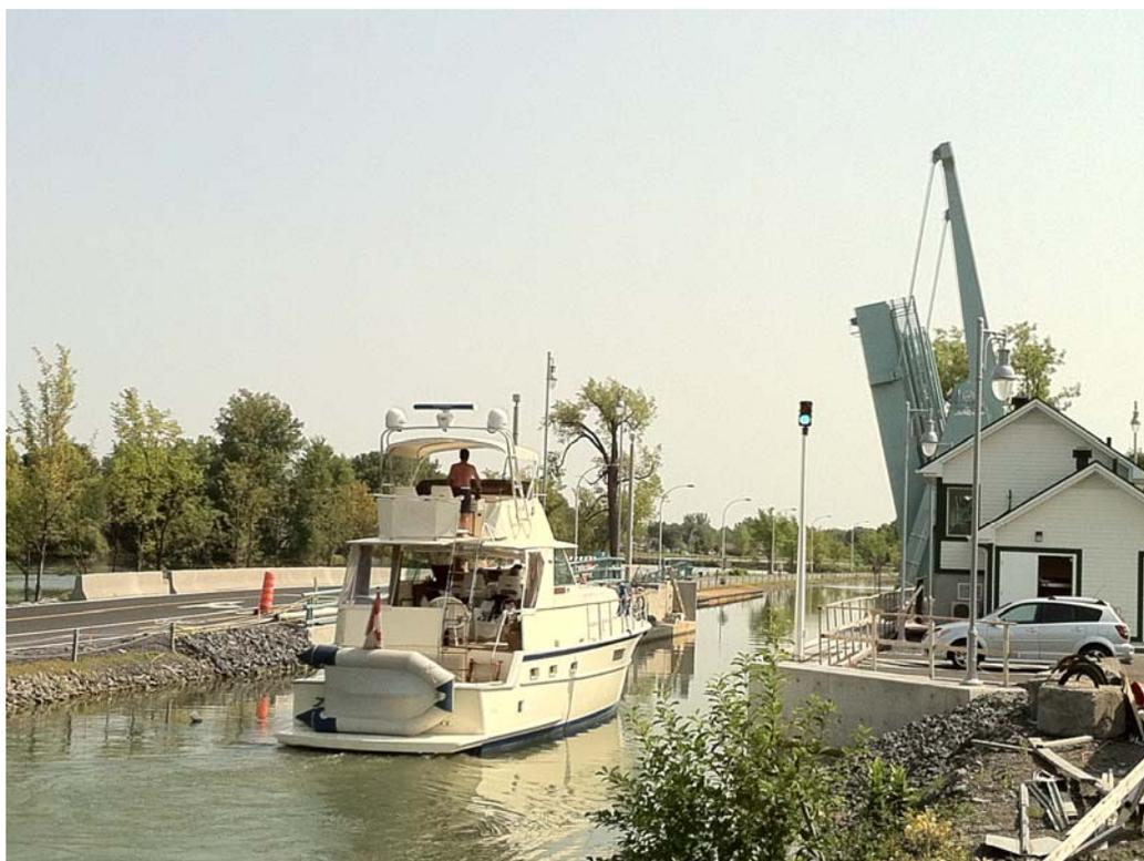
**Figure 13 – Le nouveau pont 9 – Ouverture max. (80 degrés) pour navigation**
