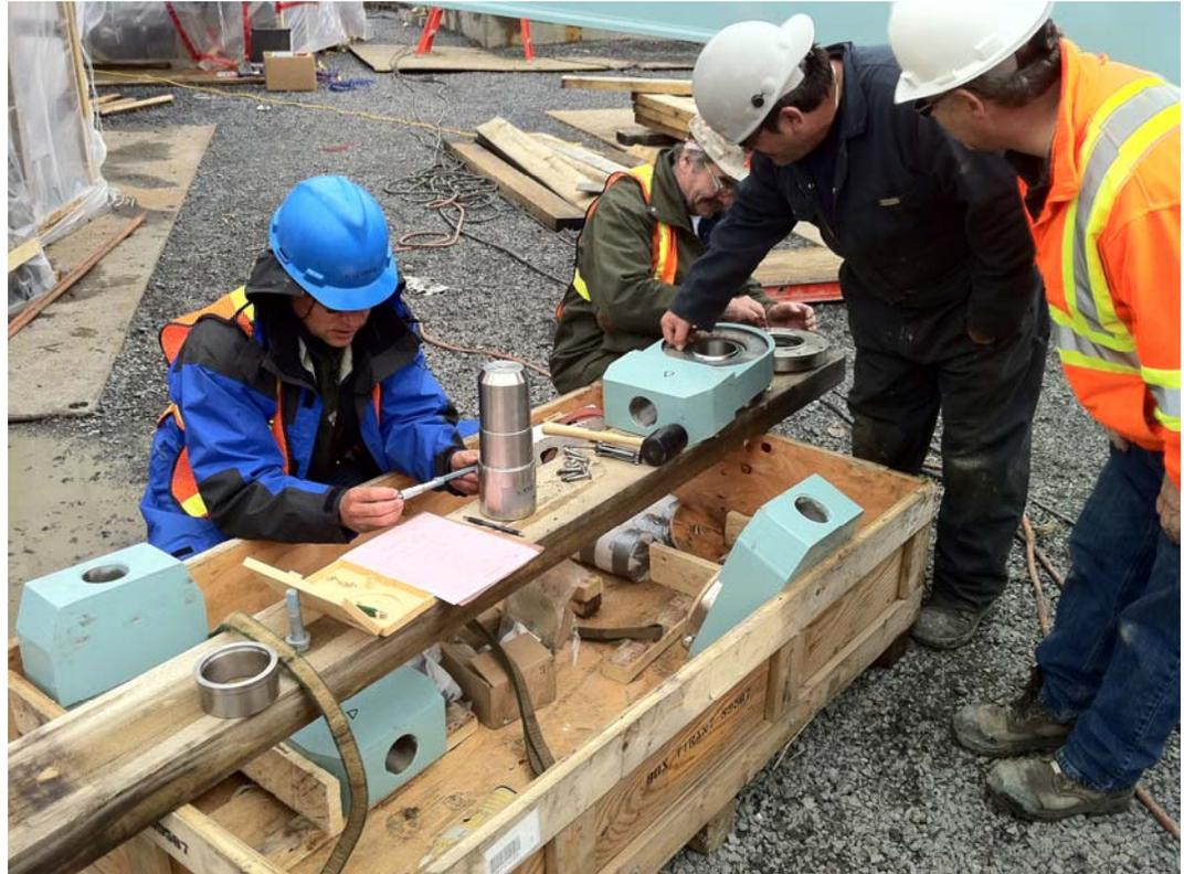
*Figure 36 – Assemblage des rotules au chantier par « shrinkfit »*
