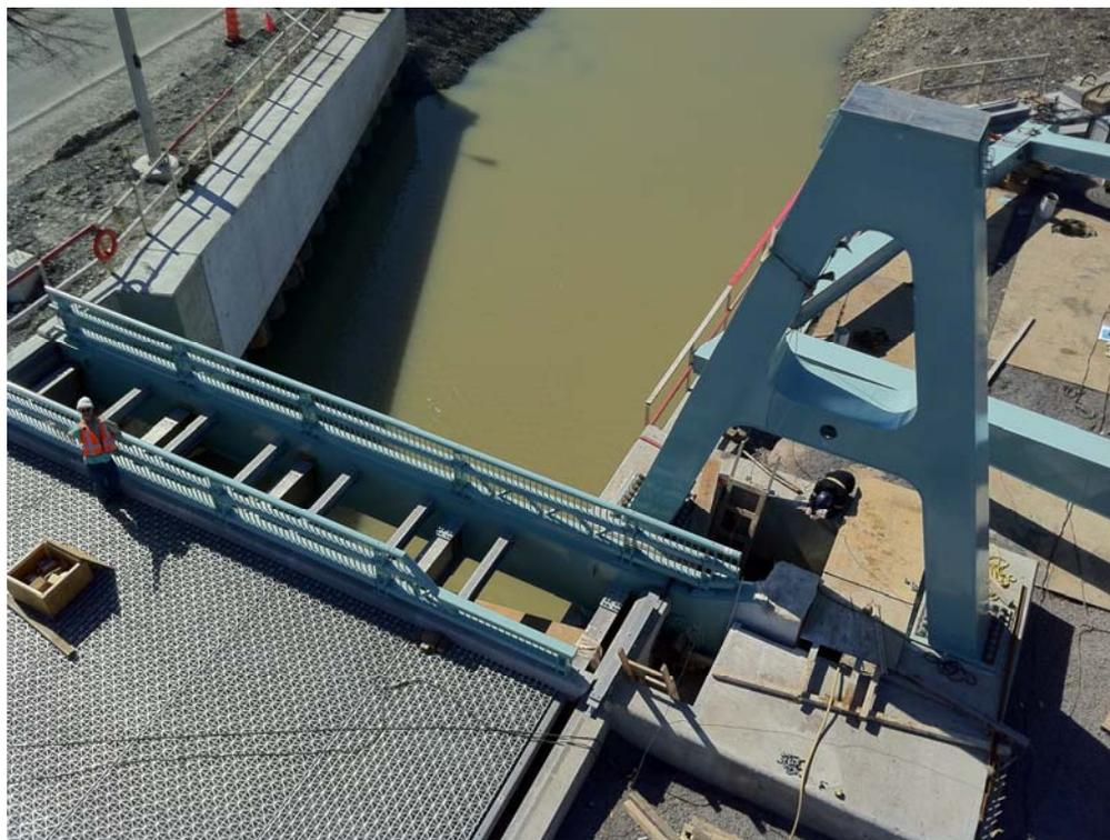
*Figure 31 – Tablier en cours d'assemblage et cadres en « A » en place*
