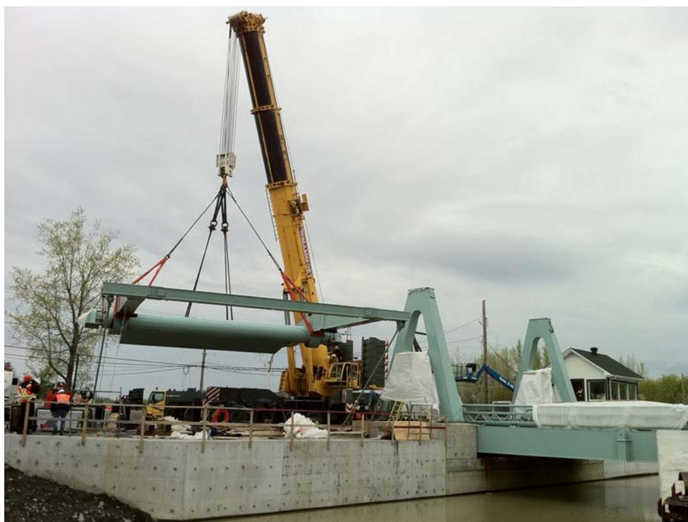
*Figure 33 – Levage et mise en place des éléments supérieurs*
