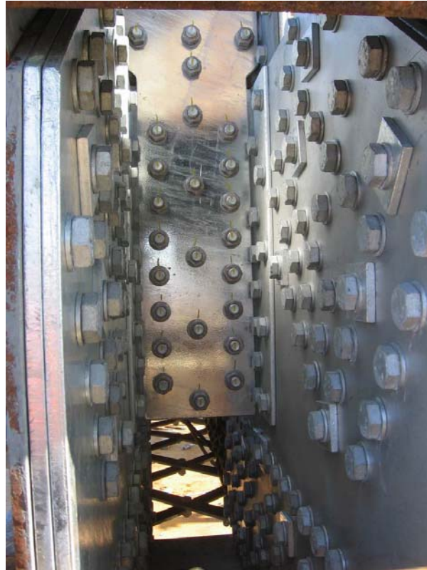
Figure 6 : Étape 6 – Vue intérieure du nœud
