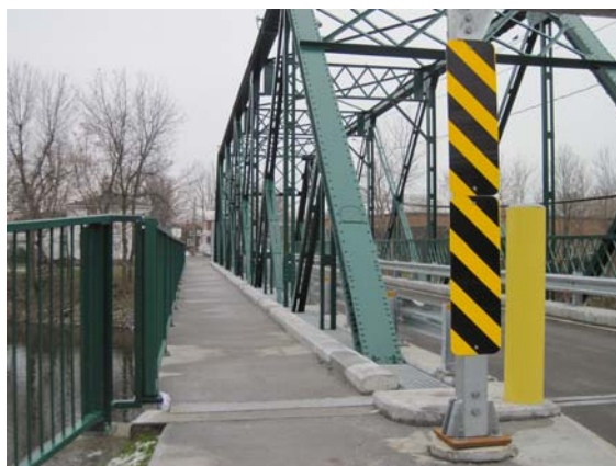
Figure 7 : Nouveau trottoir en console
