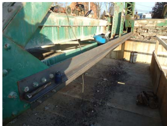
Figure 11 : Renforcement de la corde inférieure avant remplacement de la membrure
