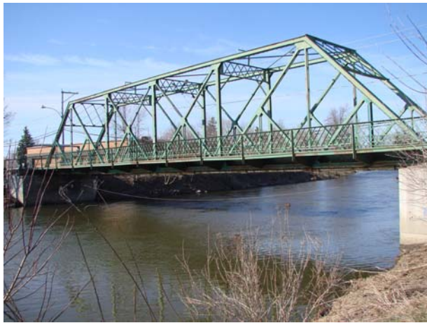
Figure 1 : Pont Walker avant réhabilitation
