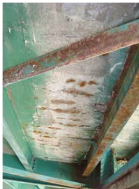
Figure 3 : Délamination de la dalle du tablier
