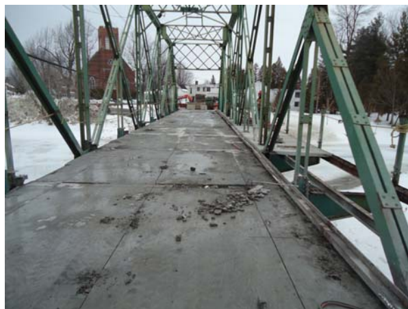
Figure 9 : Sciage du tablier
