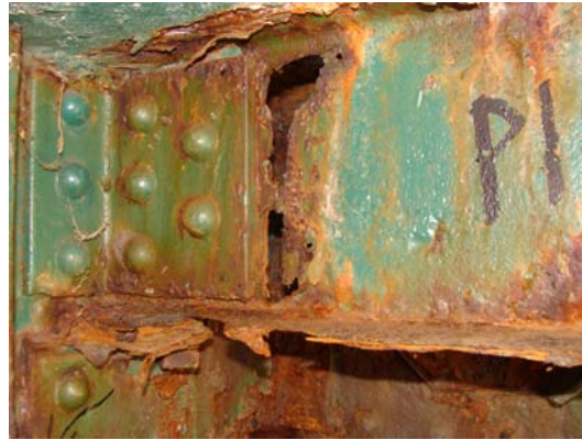
b) Perte de section d'un longeron
