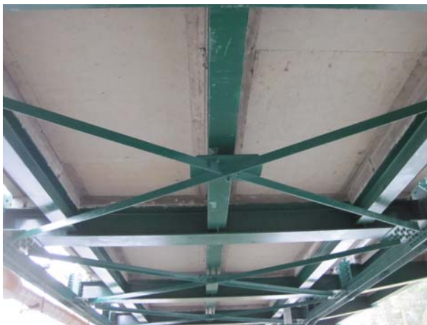
Figure 5 : Nouvelle ossature du tablier inférieur
