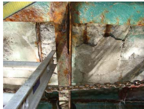
Figure 3 : Délamination de la dalle du tablier
