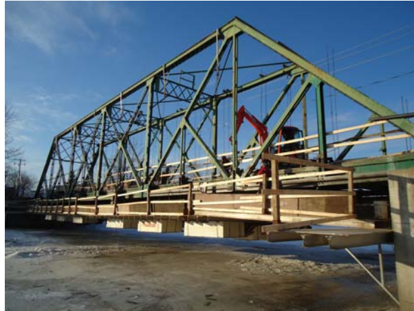
Figure 8 : Plate-forme de travail
