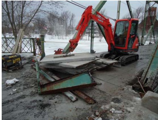
Figure 10 : Enlèvement des sections de dalle
