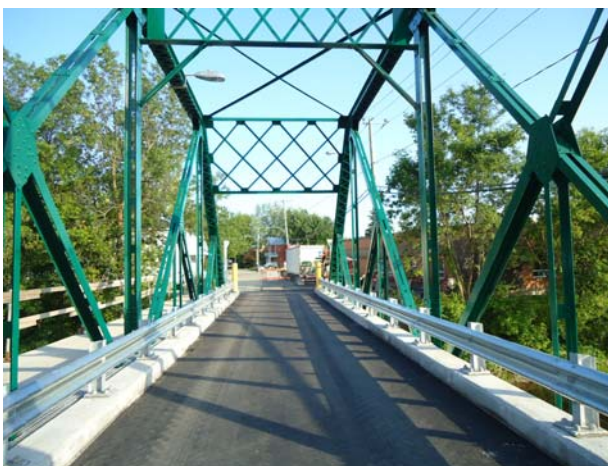
Figure 6 : Nouvelle dalle de tablier et glissière de protection
