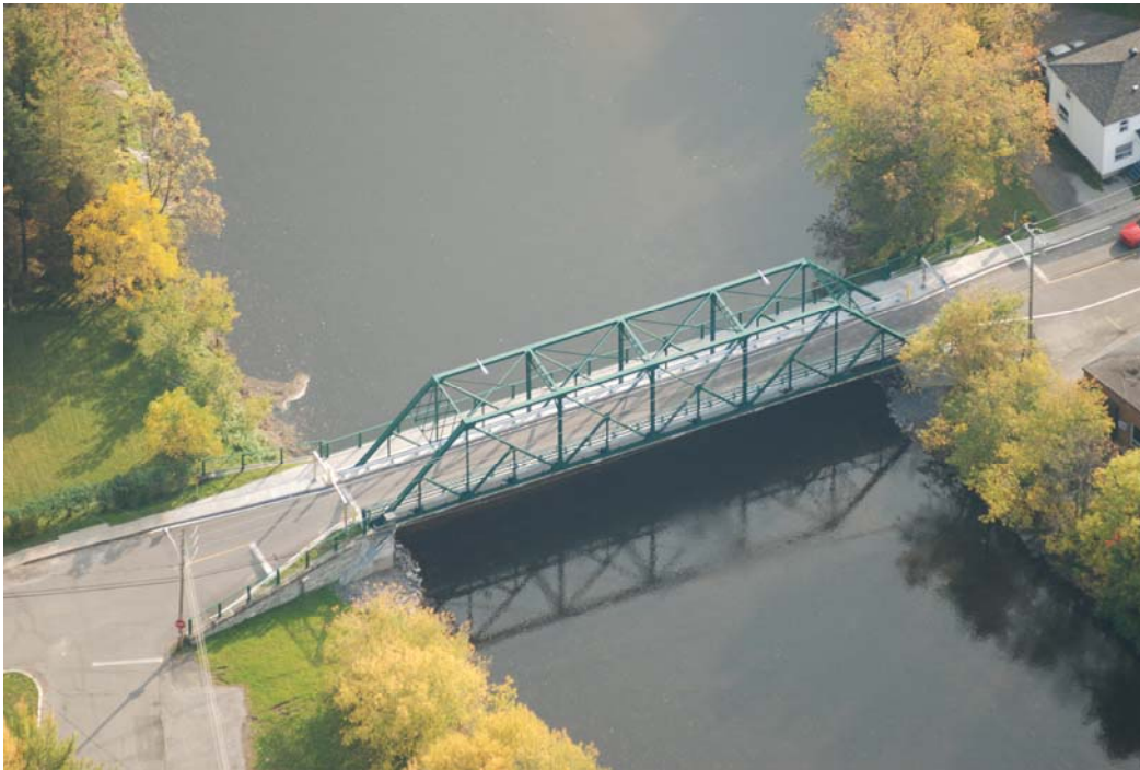
Figure 12 : Le pont Walker suite aux travaux de réfection
