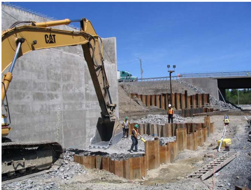
Huit plaques de tassement ont été installées pour suivre les effets du préchargement des sols porteurs situés sous les semelles des ponts de l'autoroute 85 et du boulevard Industriel. Les courbes de tassement se sont stabilisées après un délai d'environ 7 semaines (figure 11).
