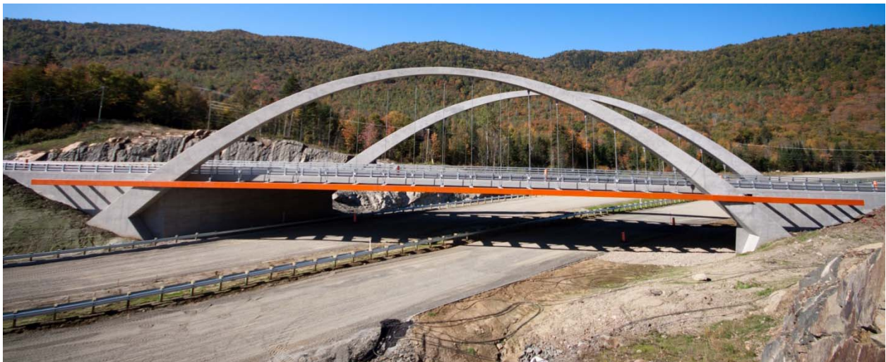
Figure 6 - Vue d'ensemble du pont
