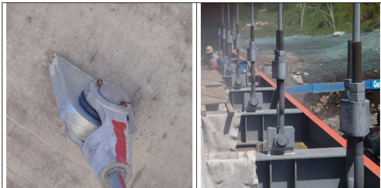
Figure 4 : Système d'attache supérieure des câbles
