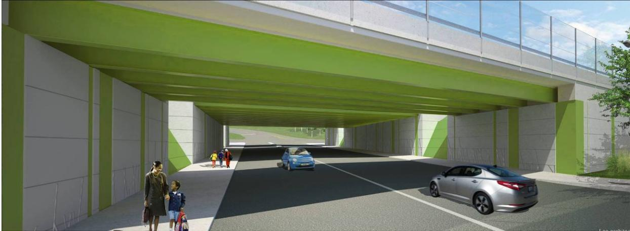
Les structures en interface avec le CUSM sont en béton et reposent sur des poutres en acier peint gris. La surface des murs en retour et des murs du soutènement de l'accès au centre hospitalier reprennent les motifs horizontaux, mais dans ce cas, ils font référence au graphisme des codes de l'ADN du génome humain.
