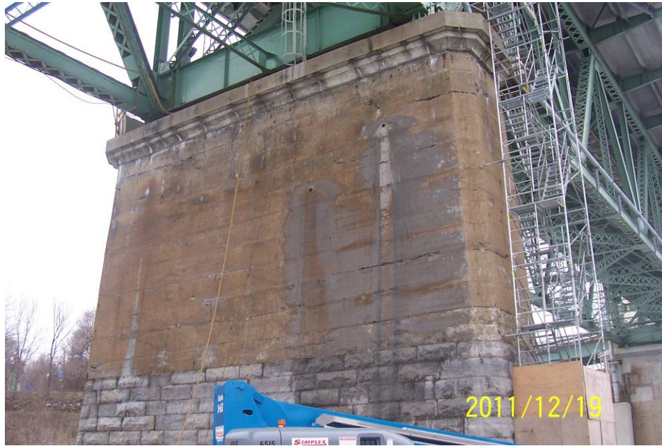
Fig. 2 : Pile 17 du pont Jacques-Cartier
