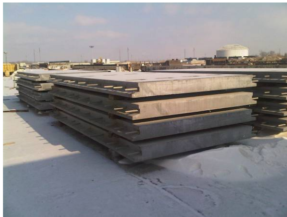
Panneaux pour le pont à Wapello County
