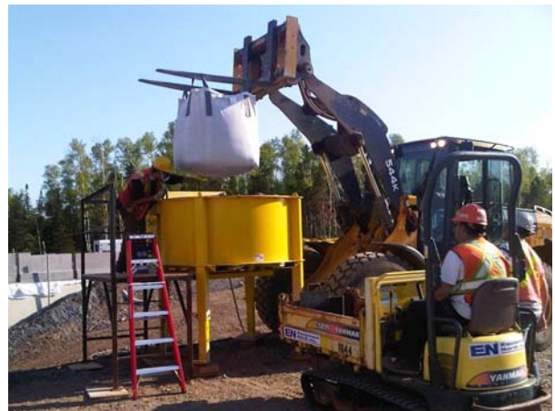
Malaxeur de 0.5 m 3
