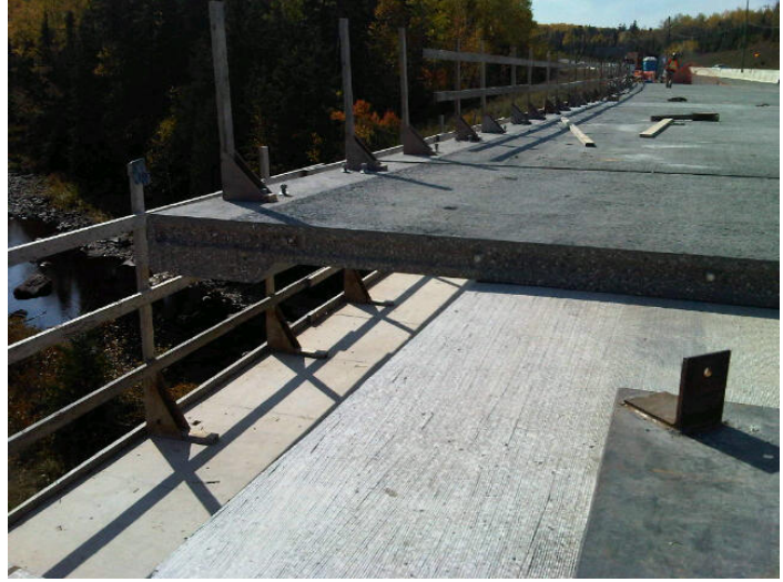
Installation du nouveau tablier – pont Current River
