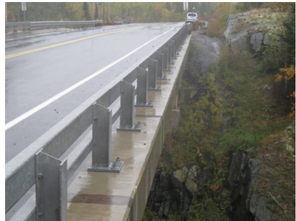
Pont Rainy Lake avec couche de bitume 2010
