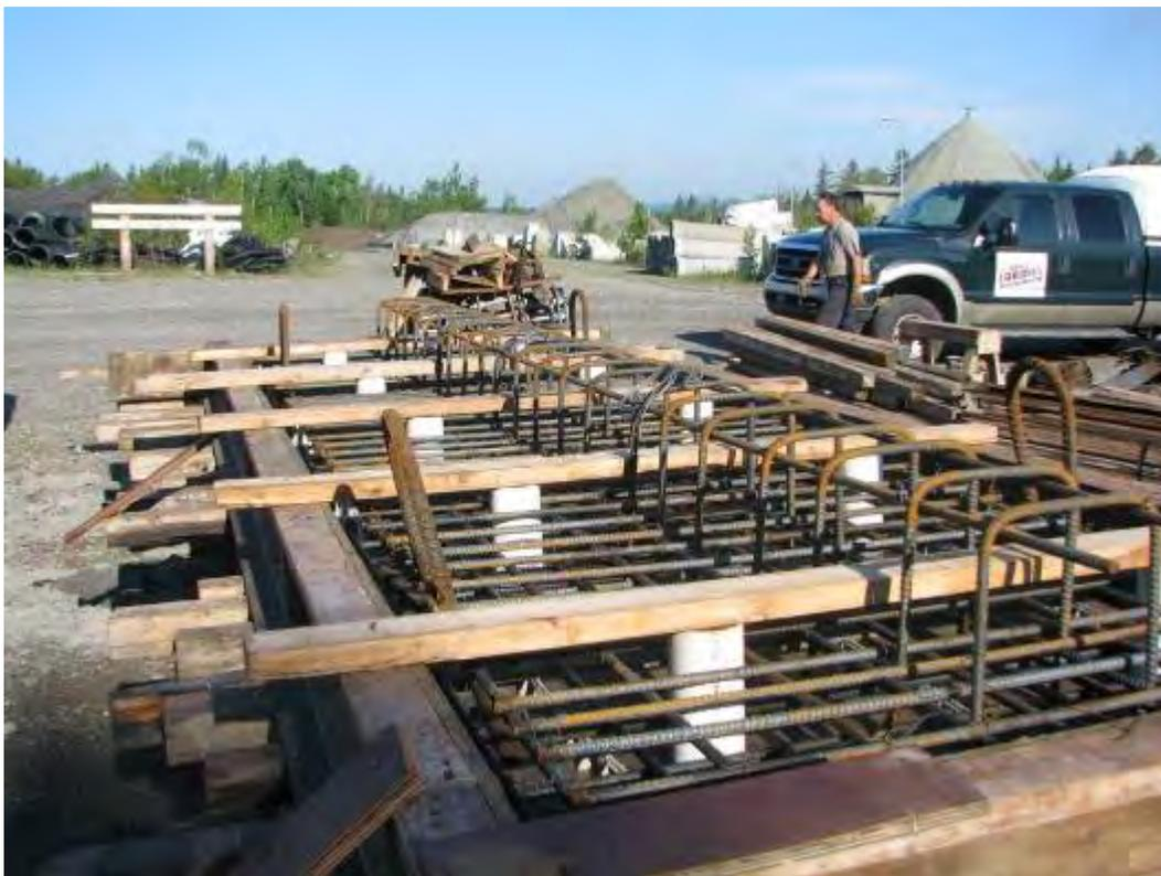
Figure 2.13: Cage d'armature des spécimens 210-Acier-5m
