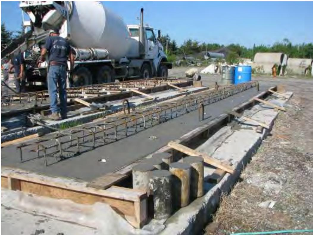
Figure 2.16: Coulée de béton des dalles des spécimens 210-Acier
