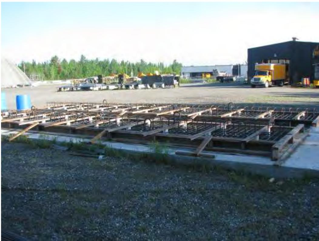
Figure 2.14: Cage d'armature des spécimens 210-Acier-11m
