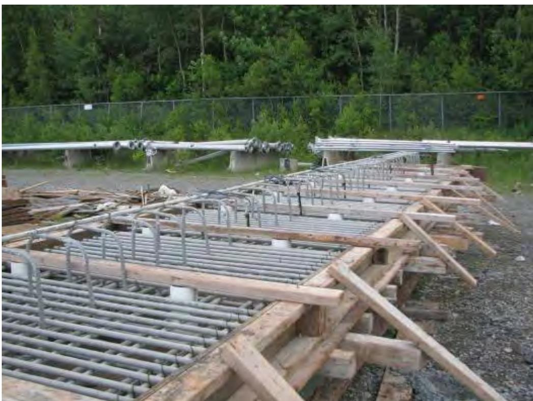
Figure 2.15: Cage d'armature des spécimens 210-PRFV-11m
