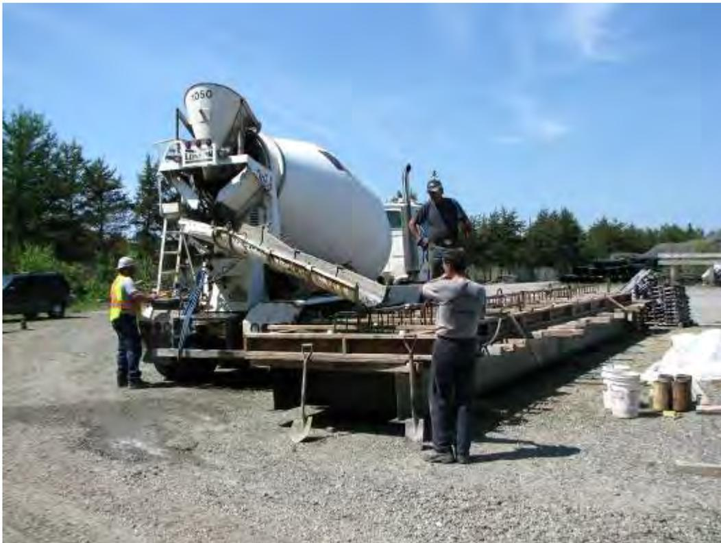
Figure 2.12: Plate-forme de travail pour la fabrication des spécimens
