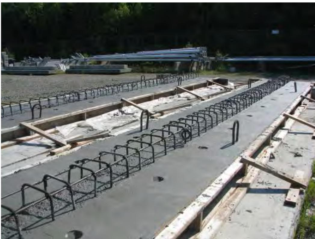
Figure 2.15 (suite): Coulée de béton des dalles des spécimens 210-Acier
