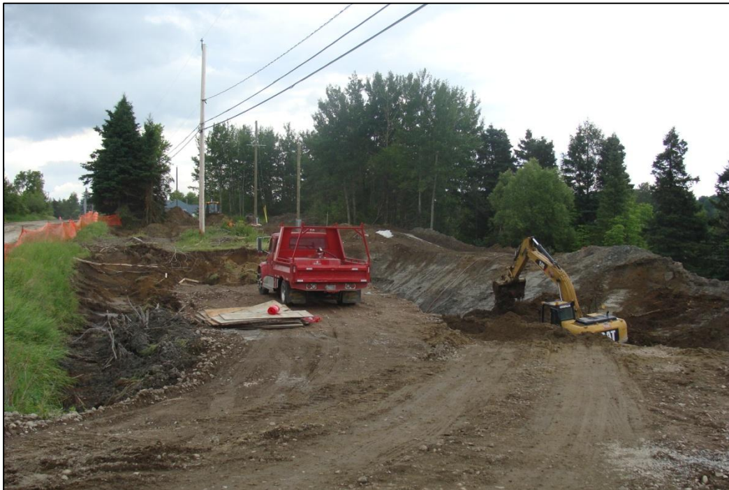
Photo 6 : projet 154-70-0012, municipalité de Saguenay, autoroute entre Chicoutimi et La Baie, travaux en cours, secteur Rivière du Moulin (contrat #2). Vue vers le nord.
