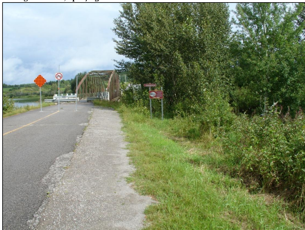
Photo 22 : projet 154-04-0442, municipalité de Hébertville, route du Bac, Lac Kénogamichiche, aperçu général du secteur d'inventaire. Vue vers le nord.
