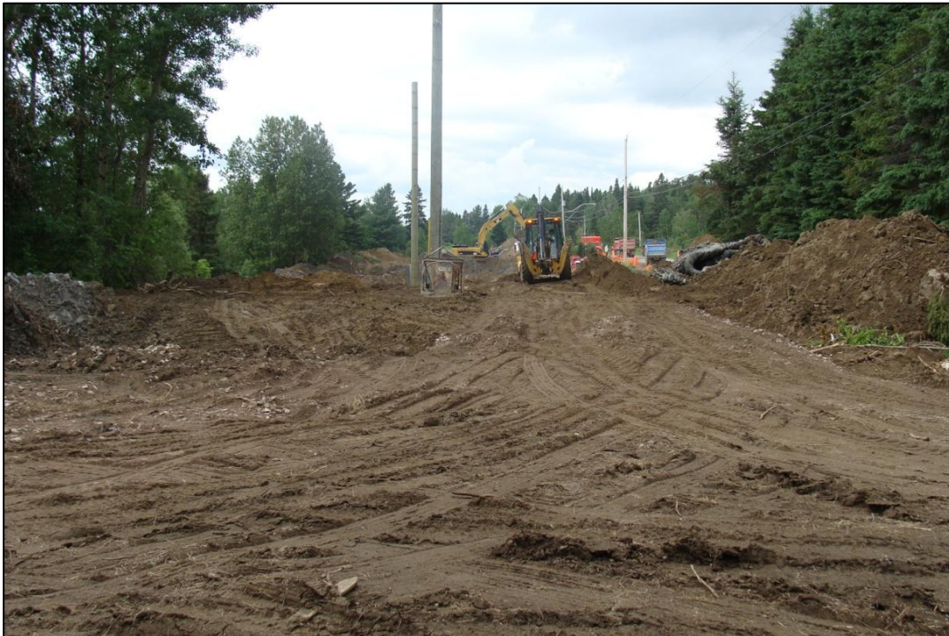
Photo 8 : projet 154-70-0012, municipalité de Saguenay, autoroute entre Chicoutimi et La Baie, travaux en cours, secteur Rivière du Moulin (contrat #2). Vue vers le nord.
