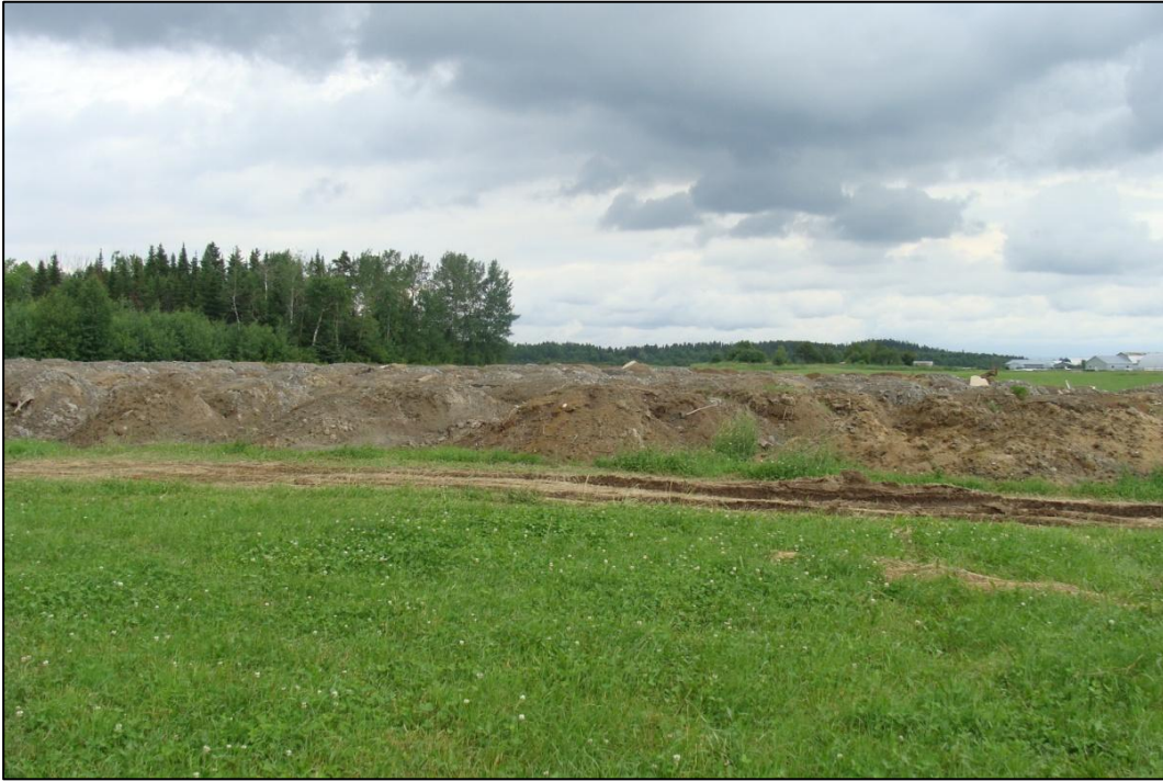
Photo 7 : projet 154-70-0012, municipalité de Saguenay, autoroute entre Chicoutimi et La Baie, travaux en cours, secteur Rivière du Moulin (contrat #2). Vue vers l'est.
