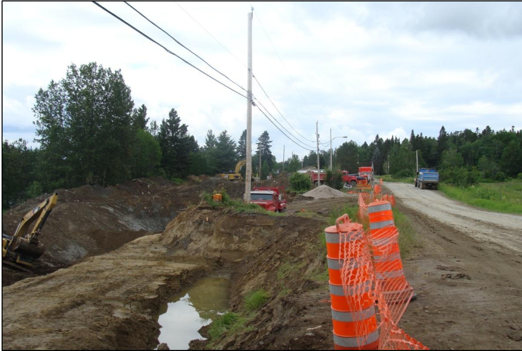
Photo 5 : projet 154-70-0012, municipalité de Saguenay, autoroute entre Chicoutimi et La Baie, travaux en cours, secteur Rivière du Moulin (contrat #2). Vue vers le sud.
