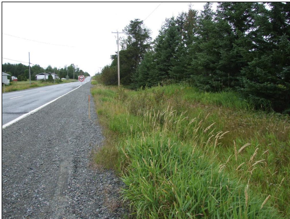
Photo 4 Secteur n°1, Ponceau n°2, sous-secteur nord-est, vers l'ouest
