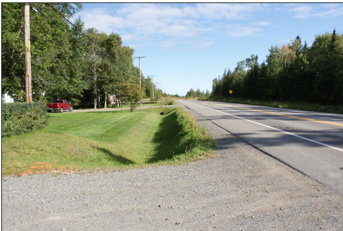
Photo 33 Secteur 3, chaînage 1+370, terrain aménagé, côté ouest de la route 397, vers le nord
