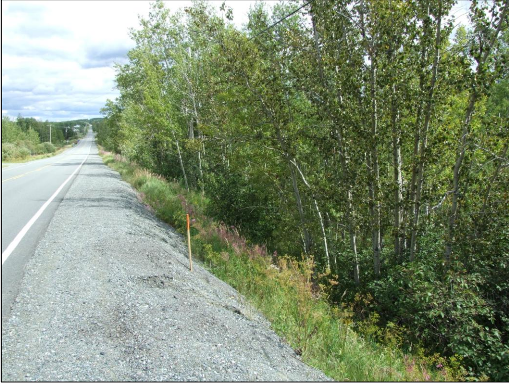
Photo 9 Secteur n°3, sous-secteur sud-ouest, vers le sud-ouest
