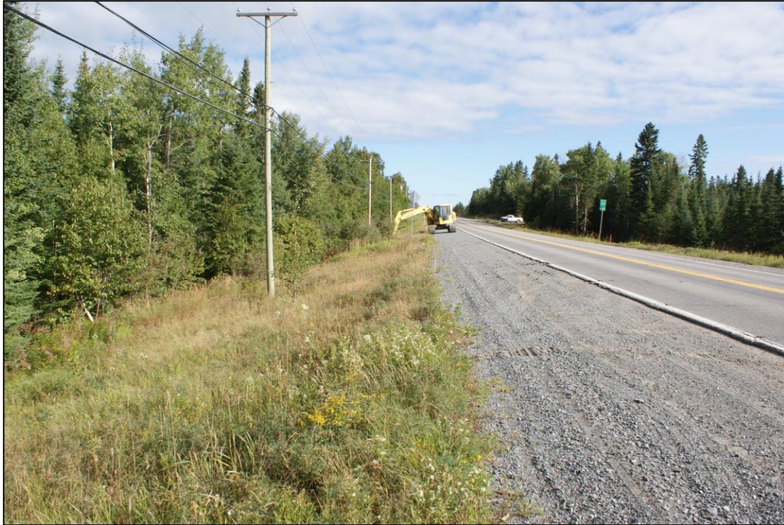
Photo 32 Limite sud du secteur 3, pente et remblai, vers le nord
