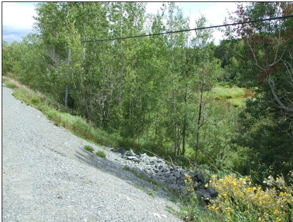
Photo 14 Secteur n°4, sous-secteur sud-est, remblais et pente, vers le sud-est
