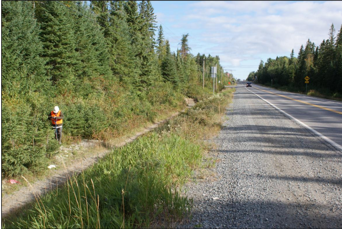
Photo 28 Secteur 1, chaînage 0+650, vue générale de la route 397, vers le nord
