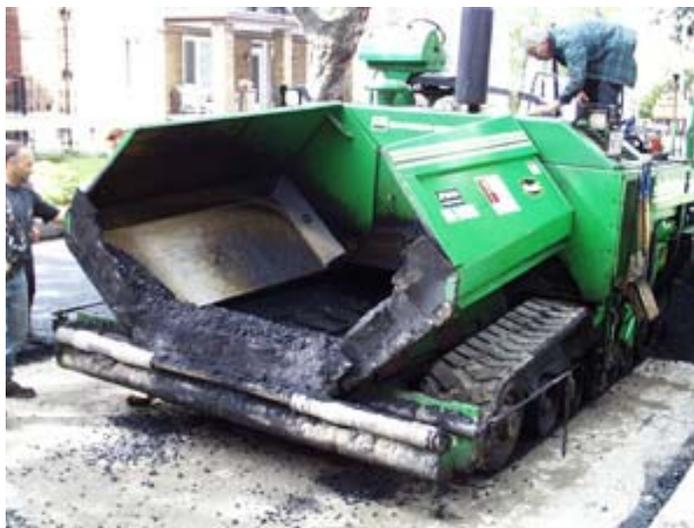
La partie arrière, soit la table lisseuse, est flottante ; c'est-à-dire qu'elle repose sur le matériau mis en place et est reliée au tracteur par l'intermédiaire de deux points d'attache.
