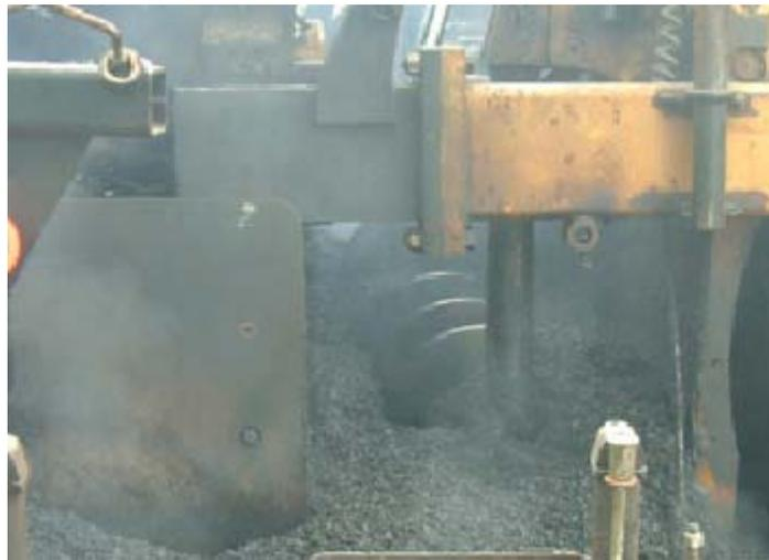
L'enrobé à chaud doit être maintenu à un niveau constant au centre de la vis de répartition ou à mi-hauteur. La quantité et l'état de l'enrobé acheminé aux vis de répartition a également un impact sur l'uniformité du mélange posé pouvant causer des ondulations et des variations de la texture en surface.
