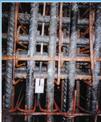
*Corde optique dans une cage d'armature.*
