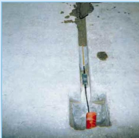
*Corde optique scellée ultérieurement dans une saignée.*
