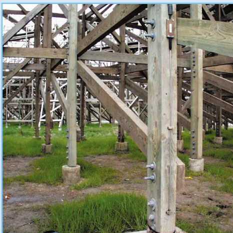
Extensomètre sur une construction en bois.
