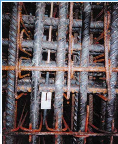
Corde optique dans une cage d'armature.
