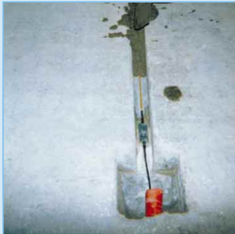
Corde optique scellée ultérieurement dans une saignée.
