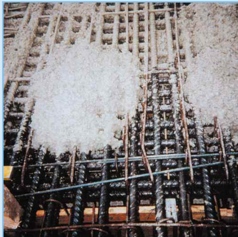
Corde optique pendant le bétonnage.
