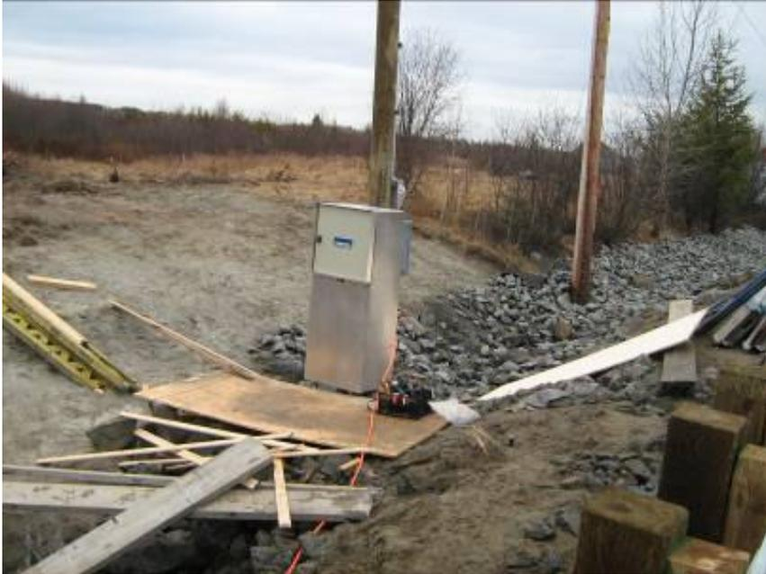
Figure 2 Centrale d'acquisition des données
