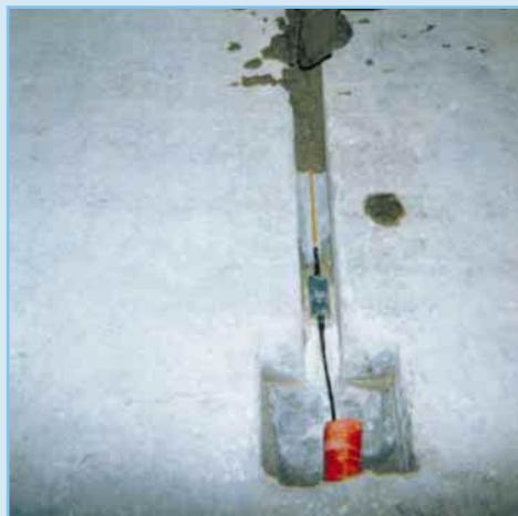
*Corde optique scellée ultérieurement dans une saignée.*
