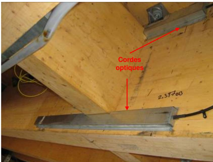
Figure 5 Cordes optiques installées en intrados et extrados sur la poutre 5 à mi-portée
