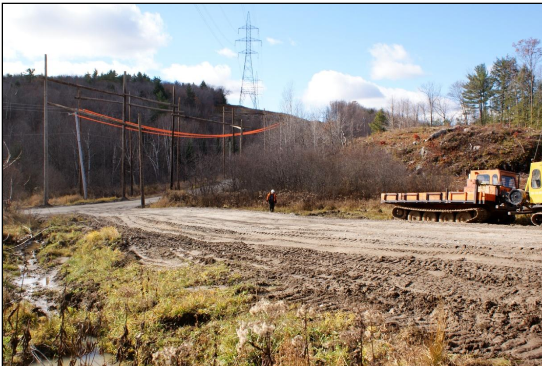
Photo 37 Chemin d'accès Hydro-Québec près du chemin St-Hyacinthe, vers le chaînage 320+340, zone Papineauville, secteur 10, direction nord-ouest
