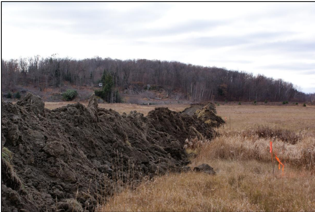
Photo 36 Excavation en tranchée, zone Papineauville, secteur 10, direction ouest
