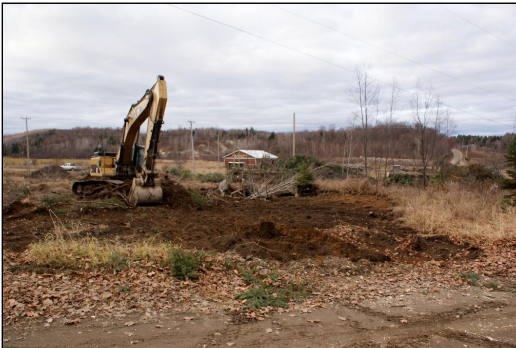
Photo 38 Déboisement et excavation des fondations d'une maison, zone Papineauville, secteur 10, direction ouest
