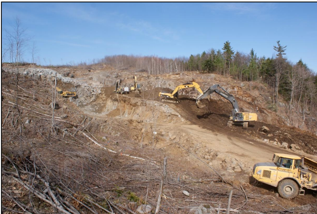
Photo 29 Emprise des travaux, zone de Papineauville, secteur 8, direction nord
