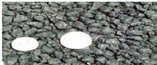
**Revêtement bitumineux poreux** - revêtement bitumineux très poreux permettant d'absorber les eaux de pluie et de piéger les matières polluantes qui pourront ainsi s'oxyder et se biodégrader. Remplace avantageusement les revêtements bitumineux classiques qui ne laissent pas pénétrer les eaux de ruissellement.
