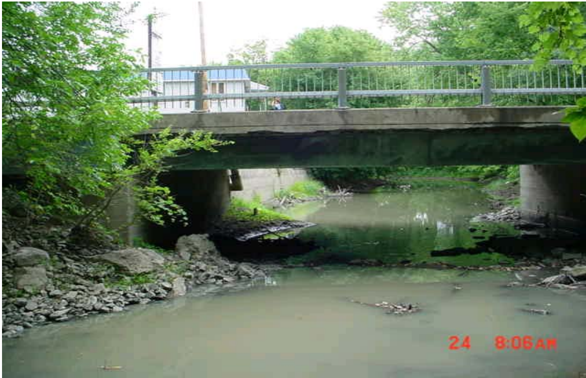
A.1(a) - Pont de la rue St-Charles
