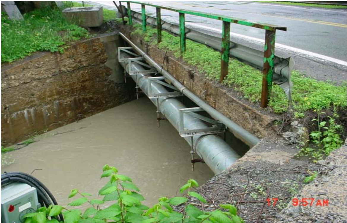
A.7(a) - Pont de la route Harwood
