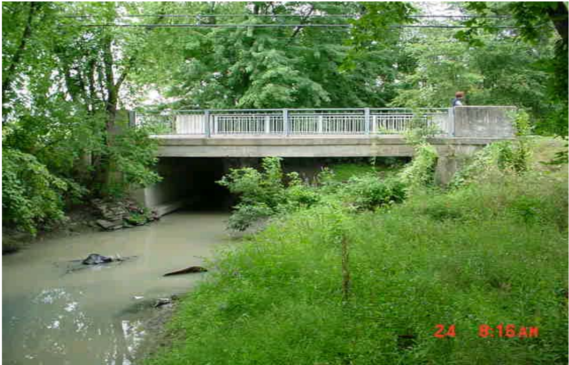
A.2(a) - Pont de la rue Ouimet
