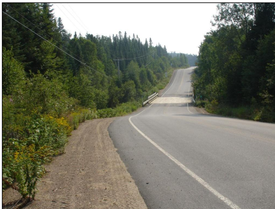
Photo 1 : projet 154-02-0714, municipalit  de Lac-Edouard, chemin du lac Edouard, apercu g n ral de la zone d'emprise. Vue vers le nord.
