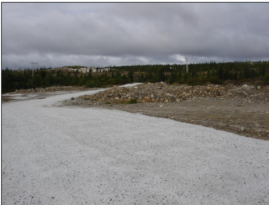
Photo 6 : projet 154-07-0362, municipalité de Rivière-Mouchalagane, route 389, km 505, aperçu général du secteur 1. Vue vers l'est.
