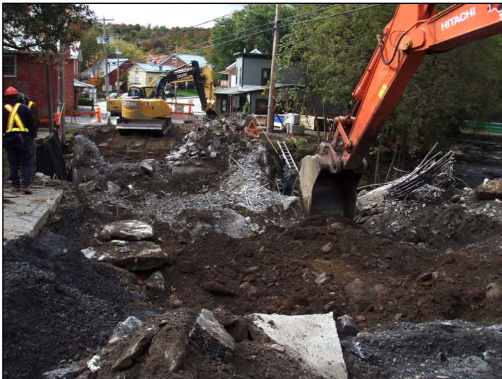
Photo 3 : Sous-opération 1A, excavation, du côté nord du pont, direction sud (154-99-0989-09-NUM1-14)
