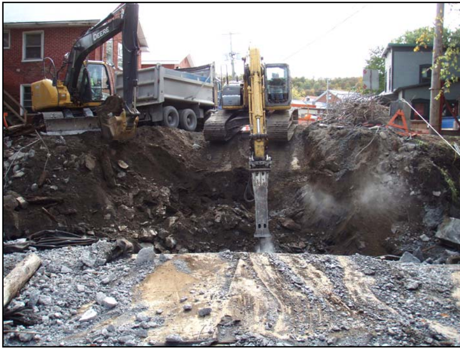
Photo 7 : Sous-opération 1B, excavation, du côté sud du pont, direction sud (154-99-0989-09-NUM1-32)
