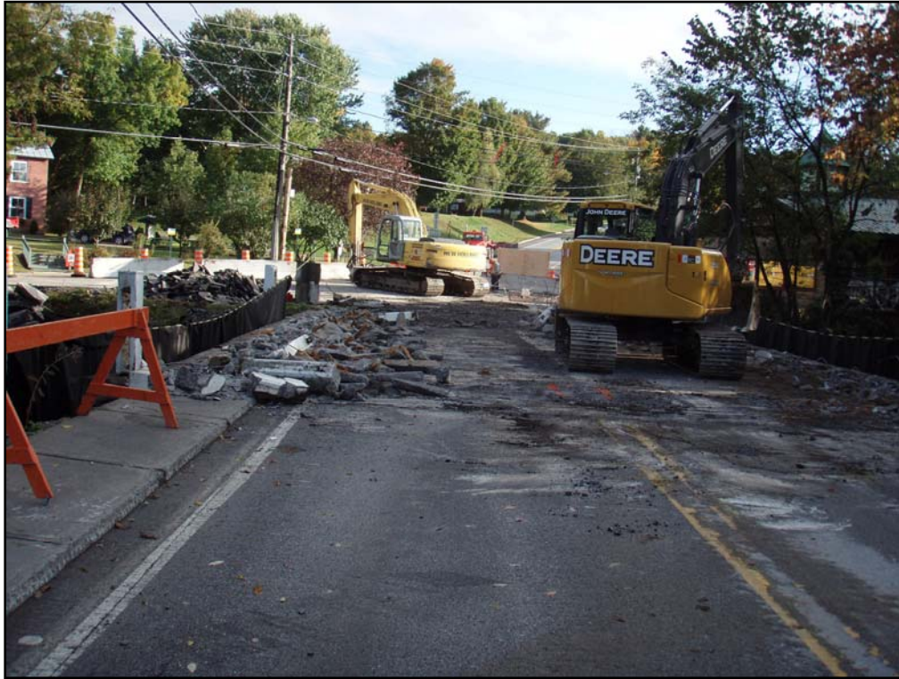
Photo 2 : Vue de l'aire de surveillance archéologique, début de la démolition du pont, direction nord (154-99-0989-09-NUM1-2)
