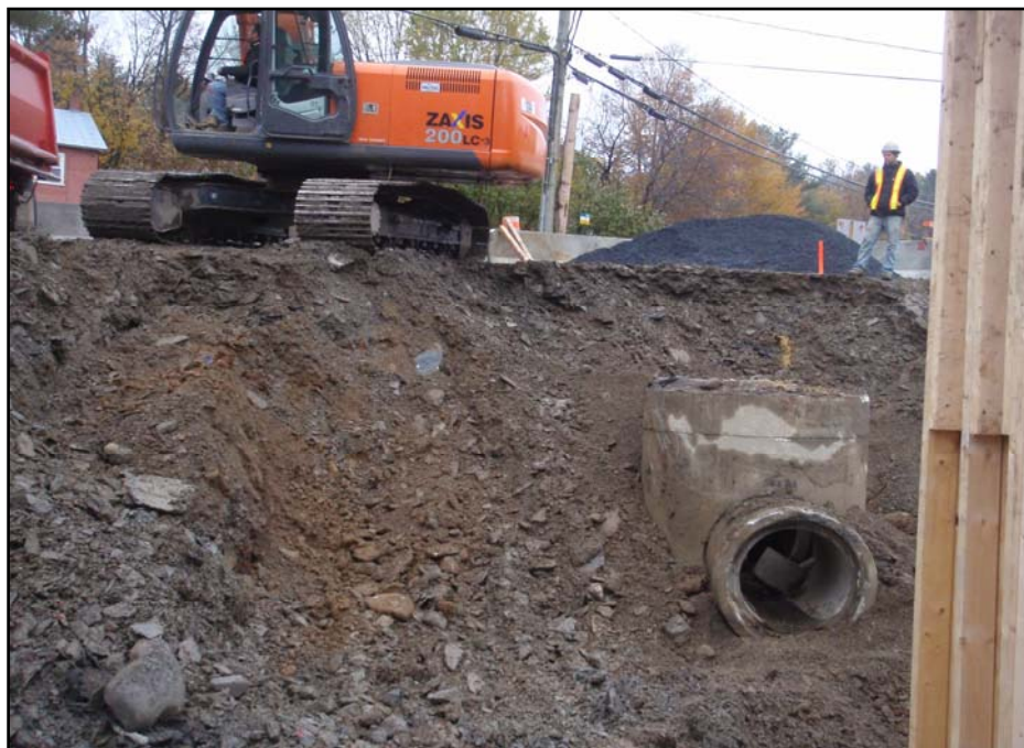
Photo 10 : Sous-opération 1C, excavation, du côté nord du pont, remplacement d'un puitsard situé directement à l'ouest de la sous-opération 1A, direction nord (154-99-0989-09-NUM1-55)
