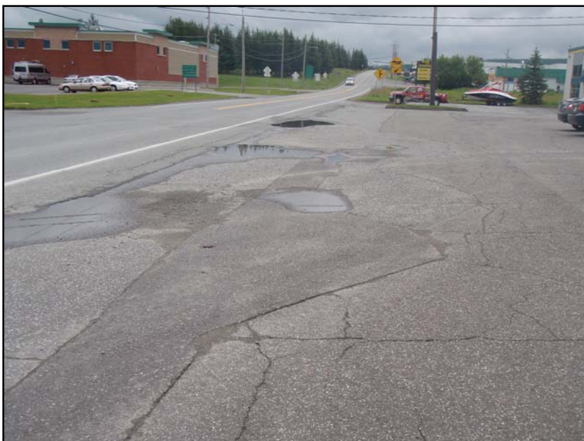
Photo 8 : Secteur 4, côté sud de la route 222, chaînages 0 + 175 à 0 + 235, direction est (154-07-0121-09-NUM1-8)
