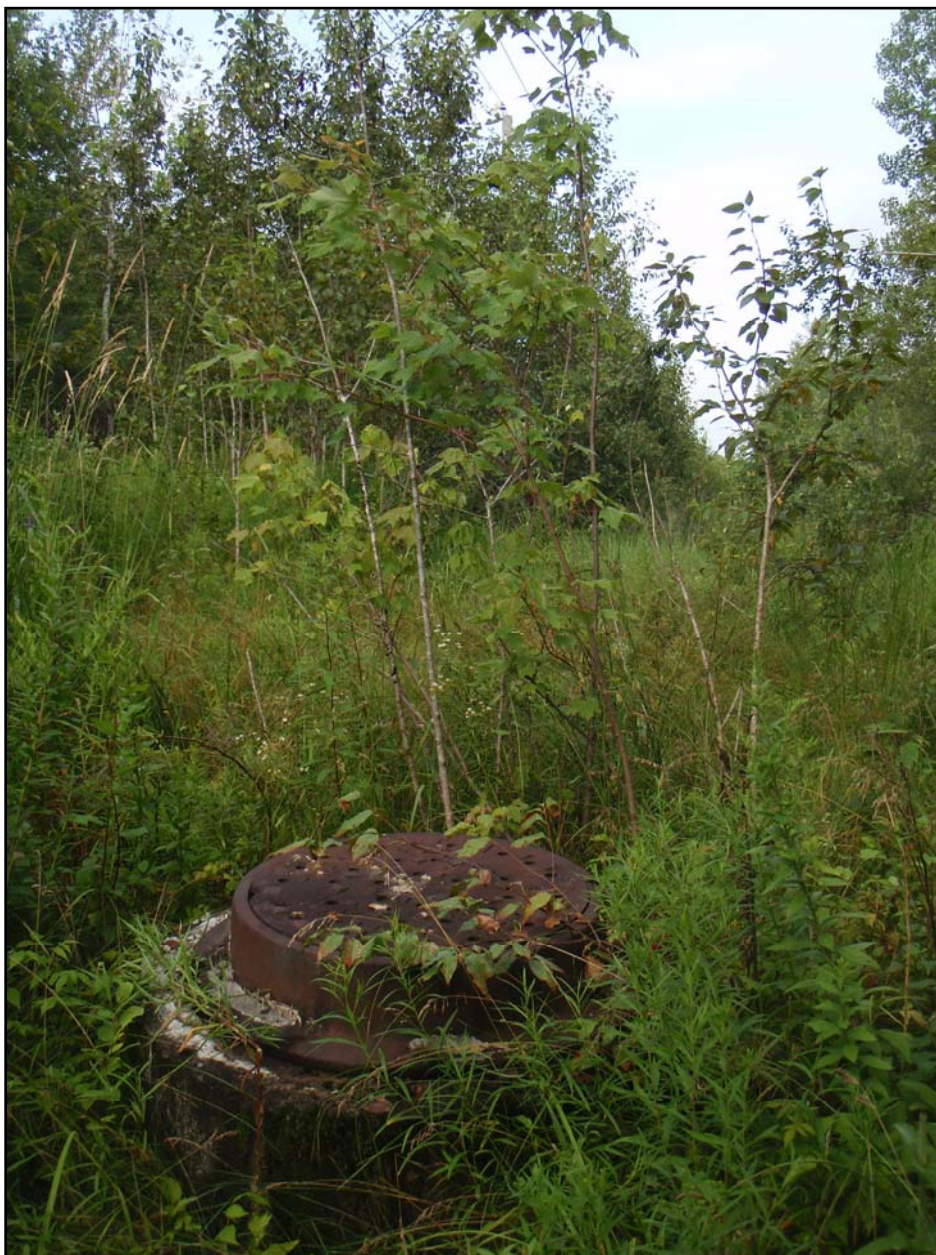
Photo 3 : Regard associé à la présence d'une canalisation d'égout, secteurs 2 et 3, direction nord (154-76-0033-09-NUM1-3)
