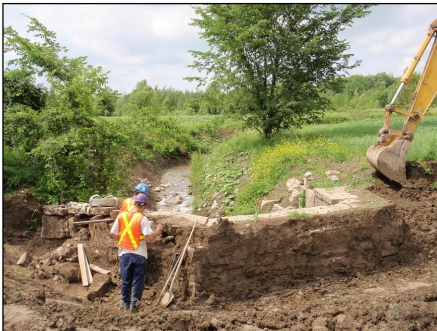
Photo 3 : Excavation derrière la structure de l'entrée de l'aqueduc n° 3, sous-opération BhFm-13-2A, direction sud-ouest (BhFm-13-09-NUM1-13)
