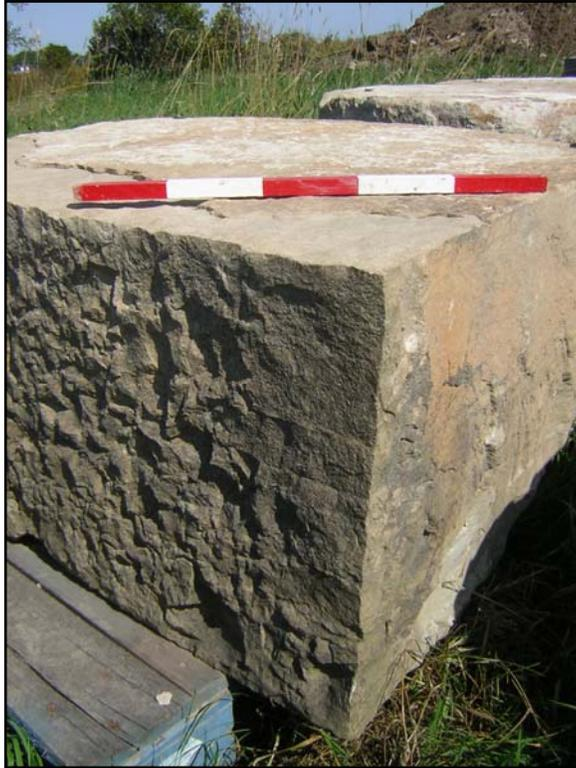
Photo 12 : Pierre soigneusement ébauchée, entrée de l'aqueduc n° 3, sous-opération BhFm-13-2A (BhFm-13-09-NUM2-71)
