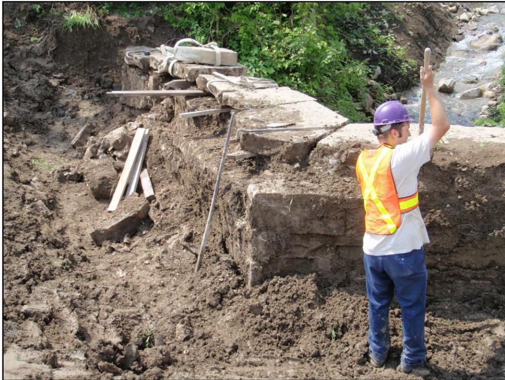
Photo 4 : Dégagement du chaperon de l'aile ouest de l'entrée de l'aqueduc n° 3, sous-opération BhFm-13-2A, direction sud-est (BhFm-13-09-NUM1-14)
