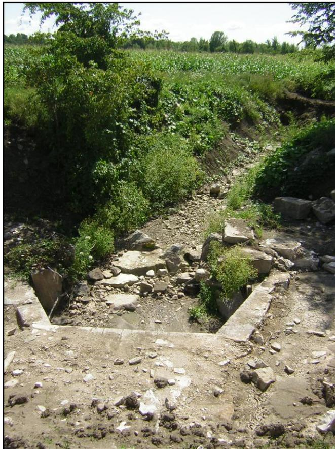
Photo 7 : Assèchement de l'entrée de l'aqueduc n° 3 après l'aménagement du batardeau, sous-opération BhFm-13-2A, direction sud (BhFm-13-09-NUM2-6)
