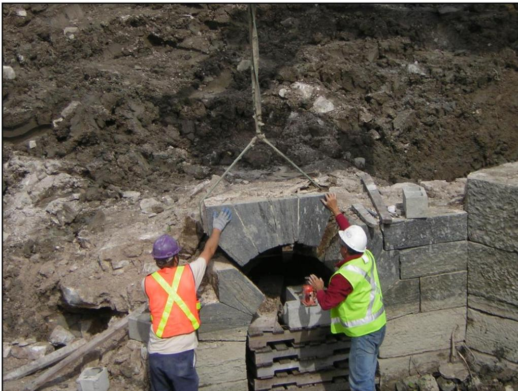
Photo 18 : Démantèlement de la voûte, entrée de l'aqueduc n° 1, sous-opération BhFI-25-2A,
