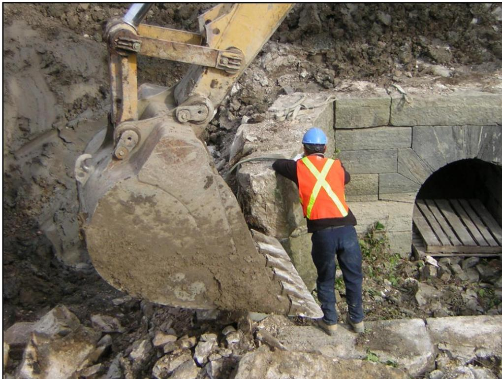
Photo 5 : Enlèvement de l'une des pierres de l'entrée de l'aqueduc n° 1 à l'aide de la pelle mécanique et de courroies en nylon, sous-opération BhFI-25-2A, direction nord (BhFI-25-09-NUM2-52)
