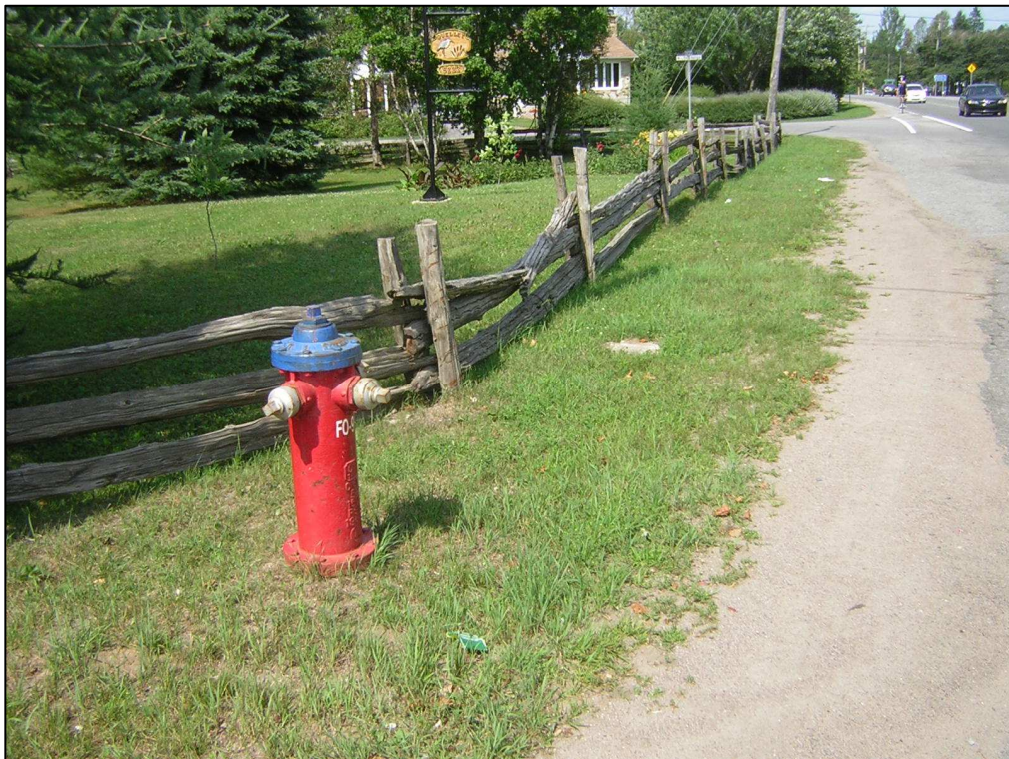
Photo 2 : Projet n° 154-03-0588, zone résidentielle du côté ouest de la route de Fossambault, au ch. 1+460, direction nord (photo n° 154-03-0588-06)
