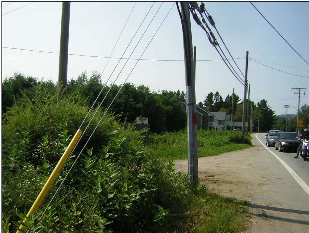
Photo 8 : Projet n° 154-03-0588, zone bouleversée pour l'aménagement de nouveaux poteaux électriques, côté sud de la route de Duchesnay, au ch. 10+000, direction ouest (photo n° 154-03-0588-31)
