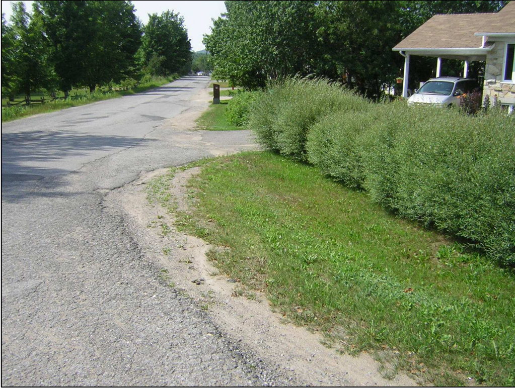
Photo 3 : Projet n° 154-03-0588, zone résidentielle du côté nord de la rue Émile-Nelligan, au ch. 1+500, direction ouest (photo n° 154-03-0588-13)
