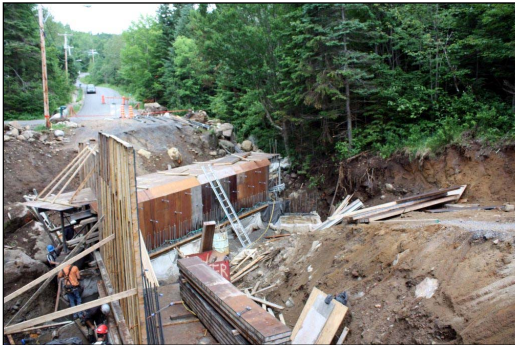
Photo 2 Projet n° 154-96-0541, vue du secteur n° 1 (travaux en cours), direction nord-ouest (PATR09N01-080)
