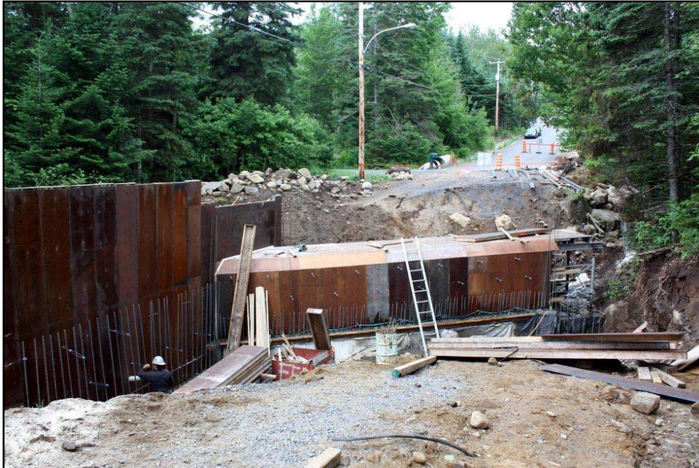
Photo 1 Projet n° 154-96-0541, vue du secteur n° 1 (travaux en cours), direction sud-ouest (PATR09N01-077)
