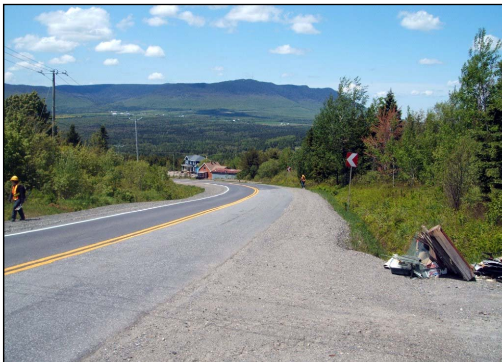
Photo 3 Projet n° 154-01-1260, secteur 2, km 5+530, environnement, direction ouest (PATR09N02-010)
