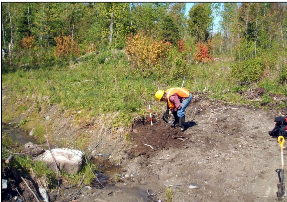
Photo 9 Projets n os 154-98-1004 et 154-98-1005, secteur 4, km 8+100, inspection visuelle, direction ouest (PATR09N02-040)
