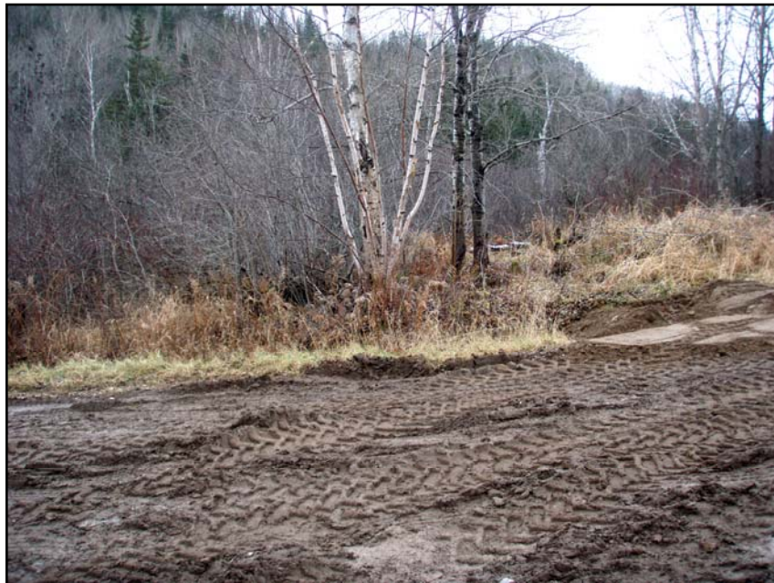
Photo 2 : Aménagement du chemin de déviation temporaire, direction sud (154-07-1773-08-NUM1-12)
