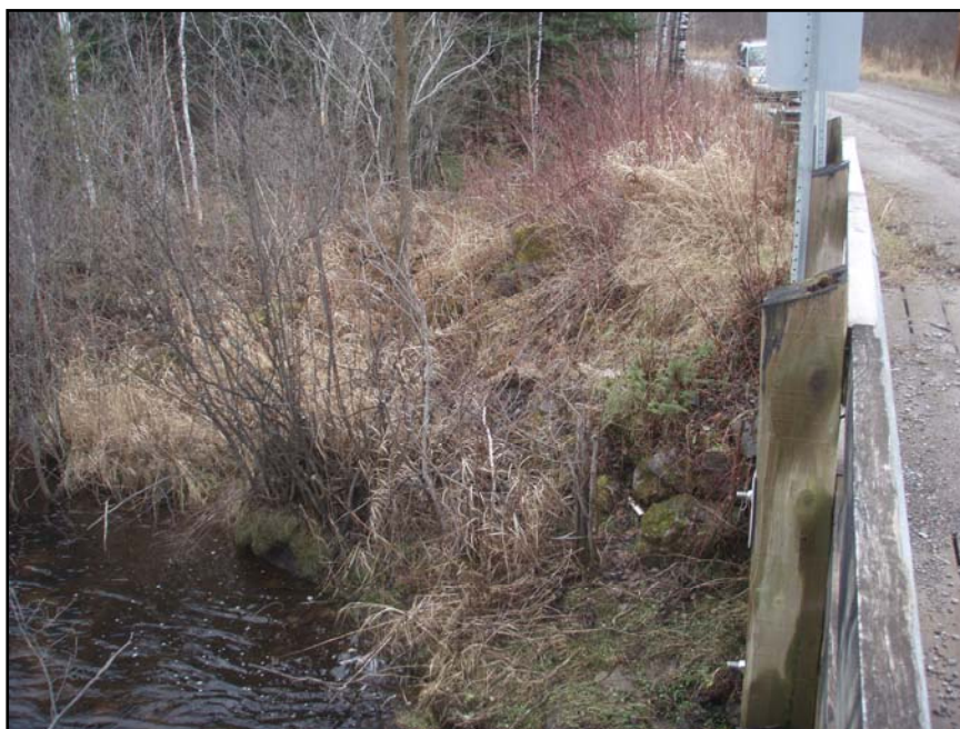
Photo 6 : Rive sud, côté est du pont, direction sud-est (154-07-1773-08-NUM1-3)
