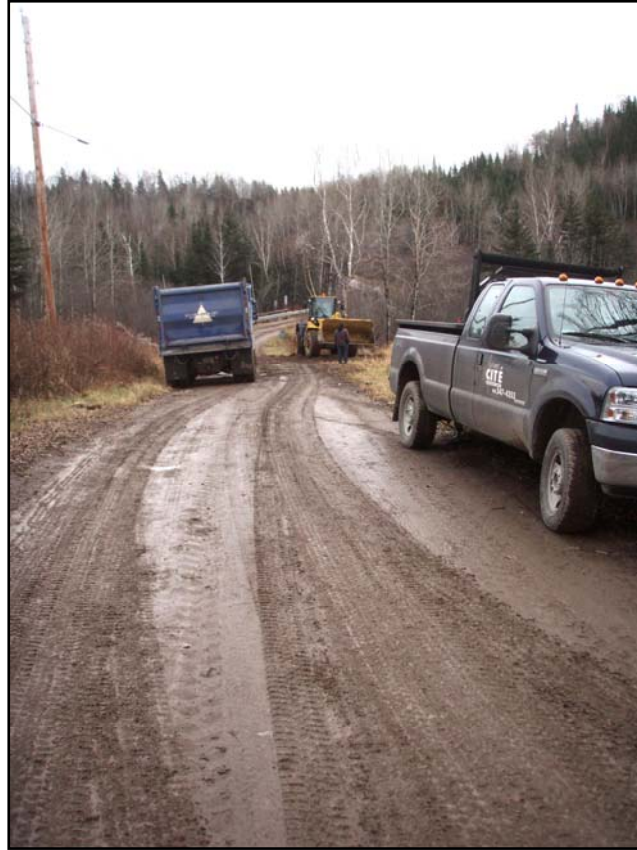
Photo 1 : Aménagement du chemin de déviation temporaire, direction nord-ouest (154-07-1773-08-NUM1-10)
