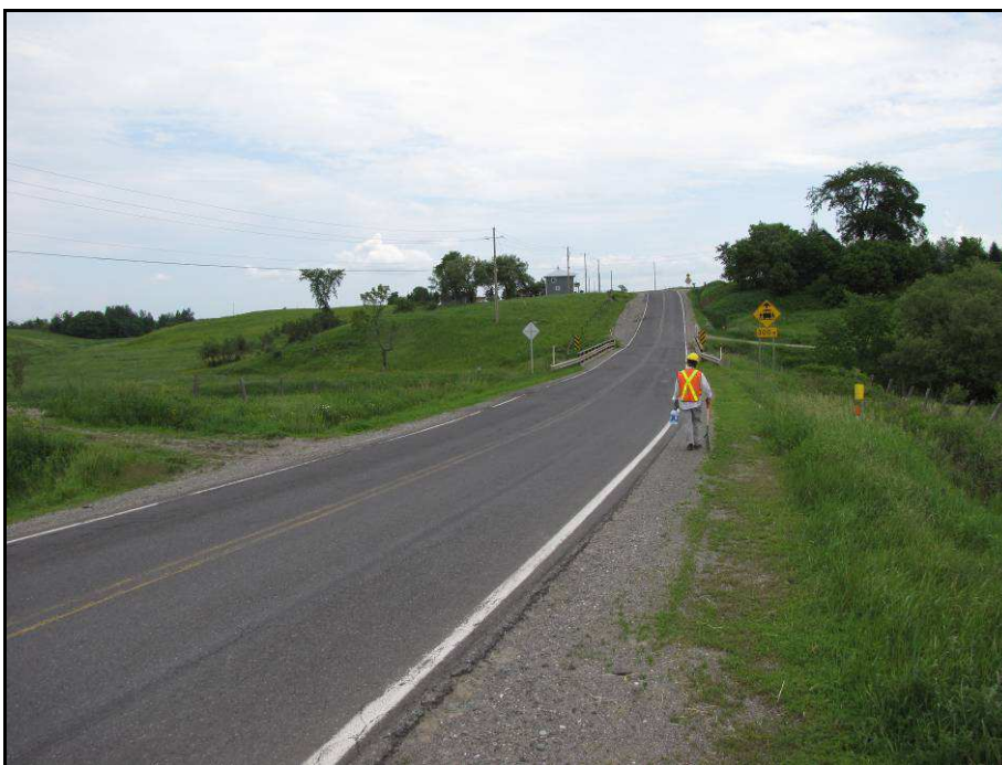
Photo 22 : Projet n° 154-94-0310, route 218, municipalité de Saint-Henri, vue générale de l'emprise du côté est du ruisseau Fourchette, du côté sud de la route 218 (photo # 154-94-0310-16)
