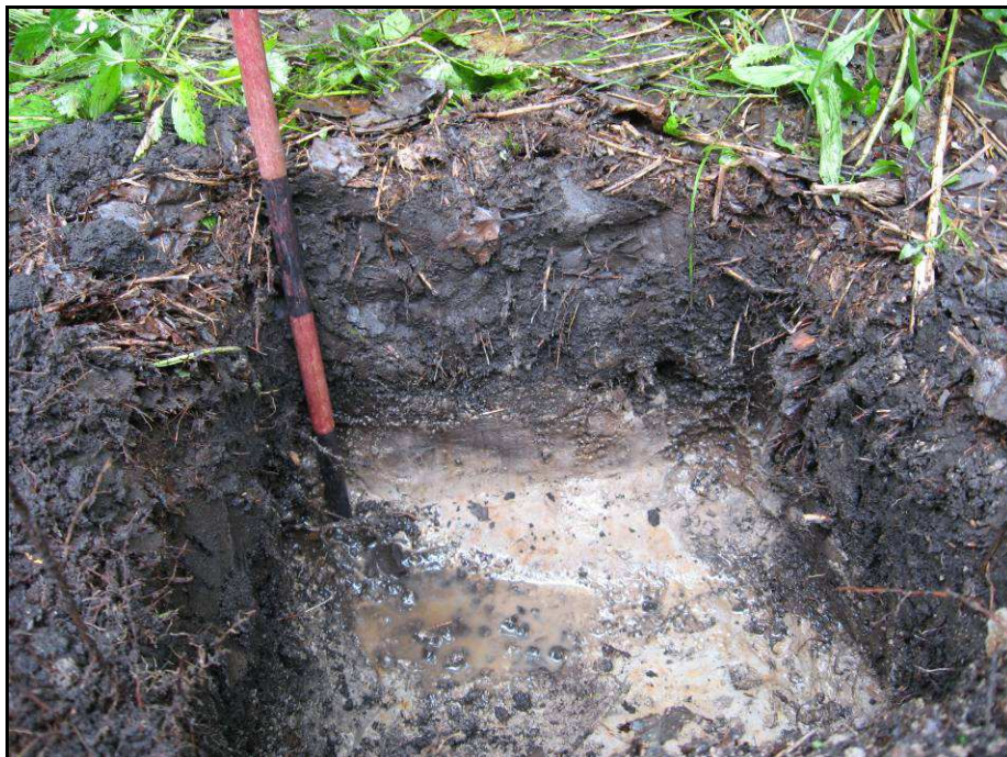
Photo 16 : Projet no 154-93-0478, route 173 et chemin Saint-Jean-Baptiste, municipalité de Saint-Henri, paroi d'un sondage du secteur A (ch 0+140), direction sud (photo # 154-93-0478-4)
