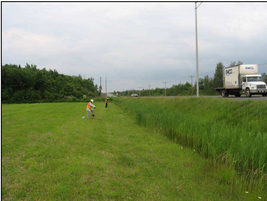
Photo 20 : Projet n° 154-93-0478, route 173 et chemin Saint-Jean-Baptiste, municipalité de Saint-Henri, vue générale de l'emprise du secteur B au ch 11+260, direction est (photo # 154-93-0478-9)
