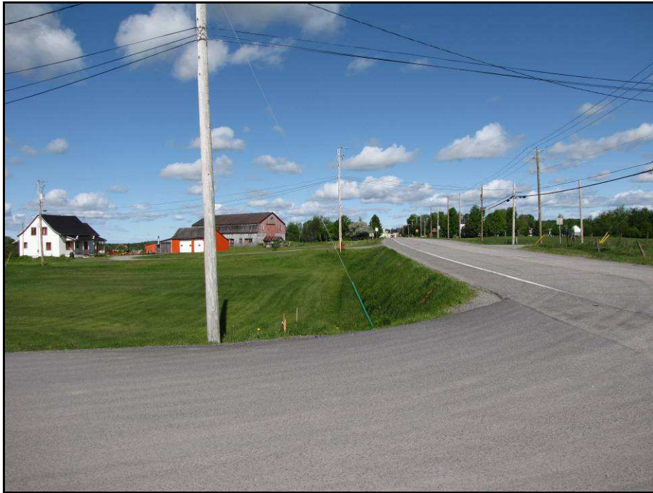
Photo 5 : Projet n° 154-00-0346, route 277, municipalité de Sainte-Claire, vue générale de l'emprise, secteur 7, côté sud de la route 277, direction ouest (photo # 154-00-0346-4)
