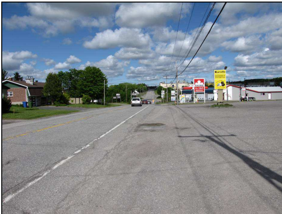
Photo 4 : Projet n° 154-00-0346, route 277, municipalité de Sainte-Claire, vue générale de l'emprise, secteur 4, côté nord de la route 277, direction ouest (photo # 154-00-0346-11)
