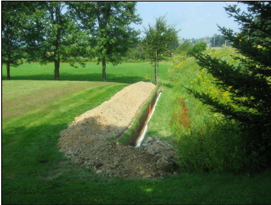
Photo 29 : Projet n° 154-99-0268, 6 e Rang, municipalité de Saint-Benoît-Labre, tranchée excavée du côté sud de la rivière Pozer, à l'ouest du 6 e Rang, direction nord (photo # 154-99-0268-20)
