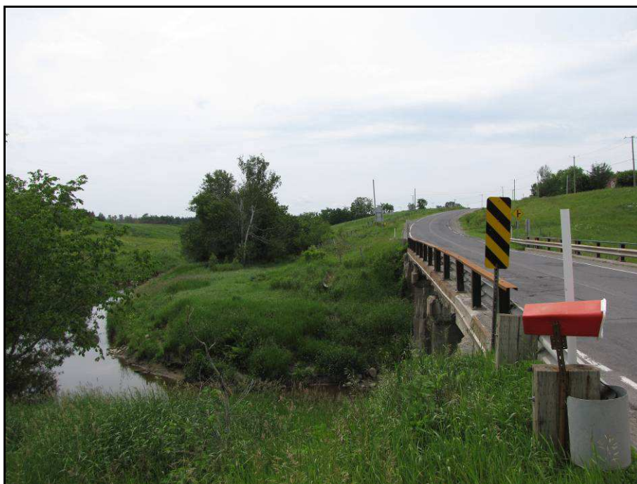
Photo 24 : Projet n° 154-94-0310, route 218, municipalité de Saint-Henri, vue générale du secteur de la voie de déviation du côté ouest du ruisseau Fourchette, du côté sud de la route 218 (photo # 154-94-0310-7)
