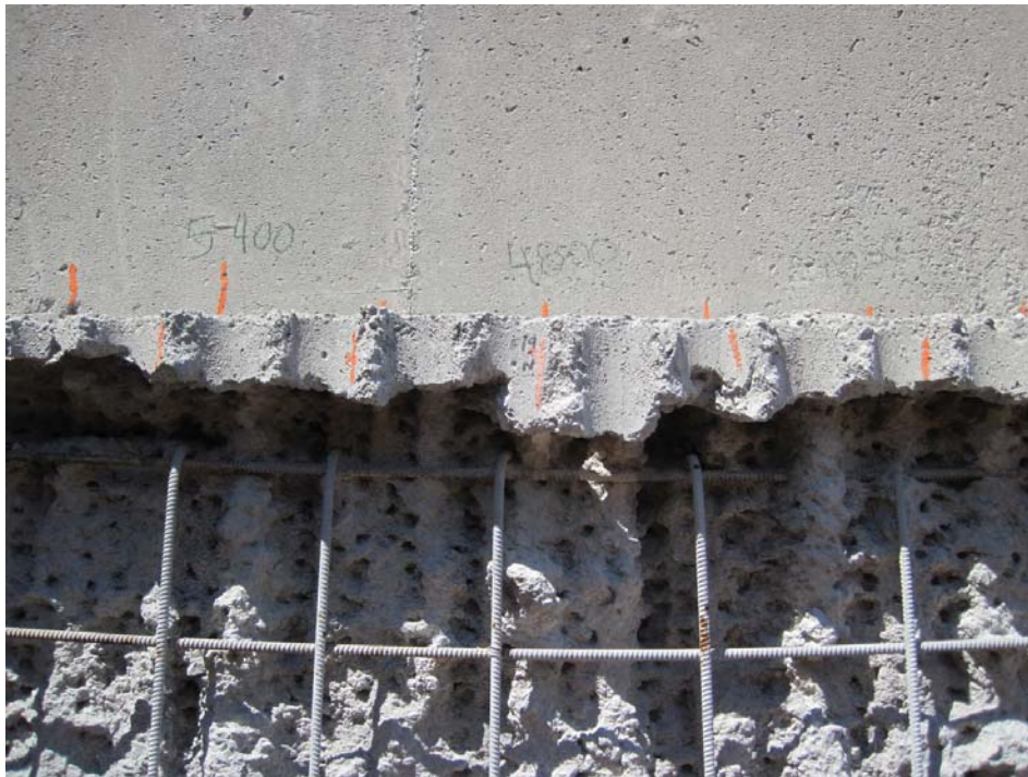
Photo 6 – Console de béton formée par l'hydro-démolition
