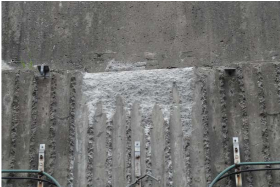
Photo 4 – Mur Sud sous la poutre P2
