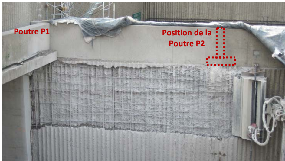
Photo 2 – Zone de démolition partielle entre les poutres P1 et P2, Mur Nord
