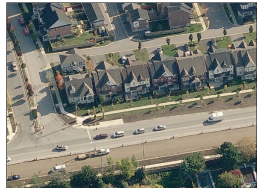
Une voie d'accès arrière permet à ces habitations de Markham de donner sur une artère à accès limité.
