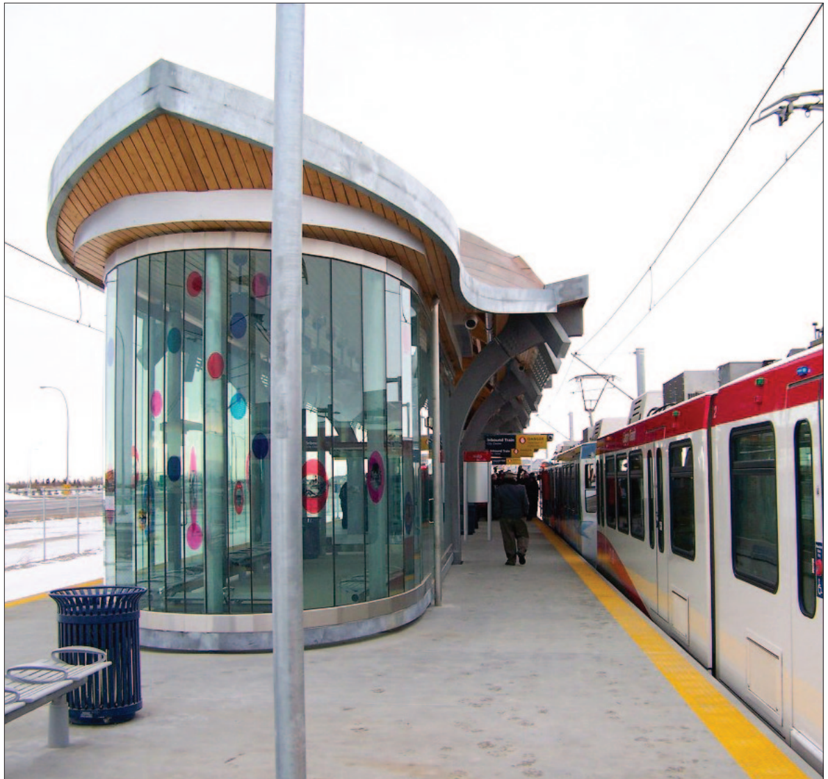
L'utilisation de verre dans cet abri à Calgary (Alberta) améliore la surveillance naturelle et l'éclairage.
