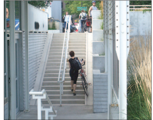
En présence d'escaliers, l'emploi de rampes à bicyclettes, comme celle de la station du Millennium Park, à Chicago, illustrée ci-dessus, facilite l'accès aux cyclistes.
