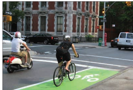
Les voies cyclables peintes aménagées en bordure, comme dans cet exemple de New York, créent un espace très visible pour les cyclistes le long des rues achalandées.
