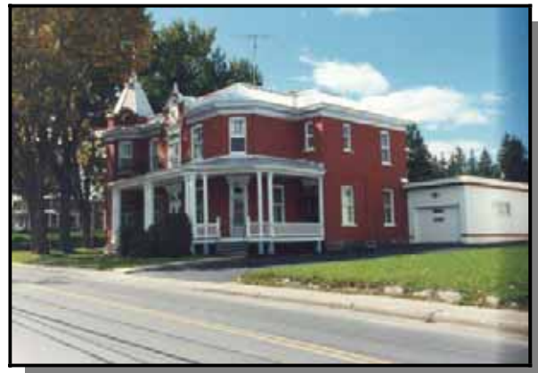
Photo 3 Bâtiment situé dans l'ensemble architectural
