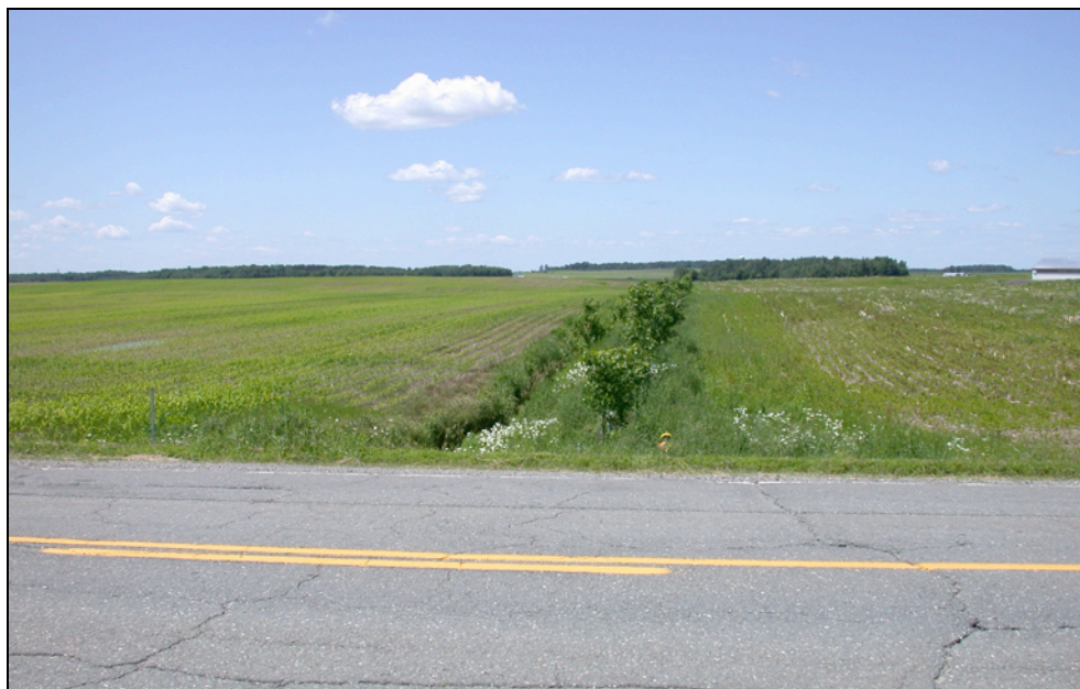
Photo 5 Projet n° 154-07-0141, secteur 1, ponceaux n° 134 000 (sud)
