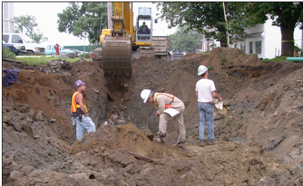
Photo 11 Projet n° 154-95-0386, tranchée au km 4+130 (ouest)
