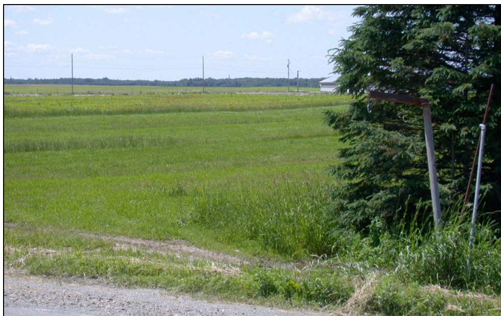
Photo 6 Projet n° 154-07-0141, secteur 2, ponceaux n° 134 002 (nord-est)
