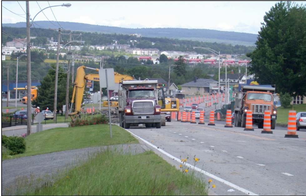
Photo 3 Projet n° 154-03-0211, secteur 1 (nord-ouest)
