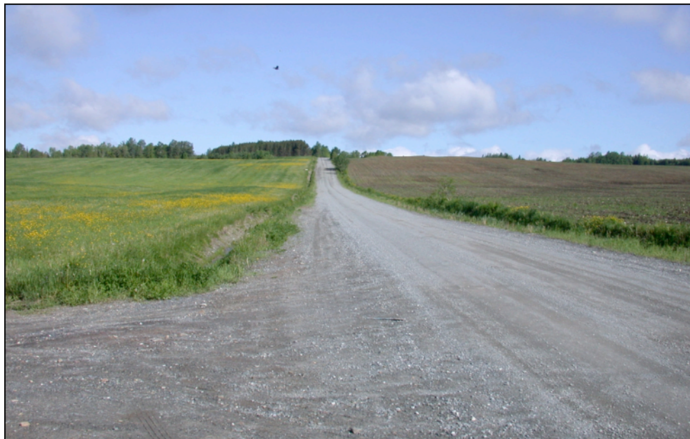
Photo 1 Projet n° 154-05-0250, secteur 1 (nord-ouest)
