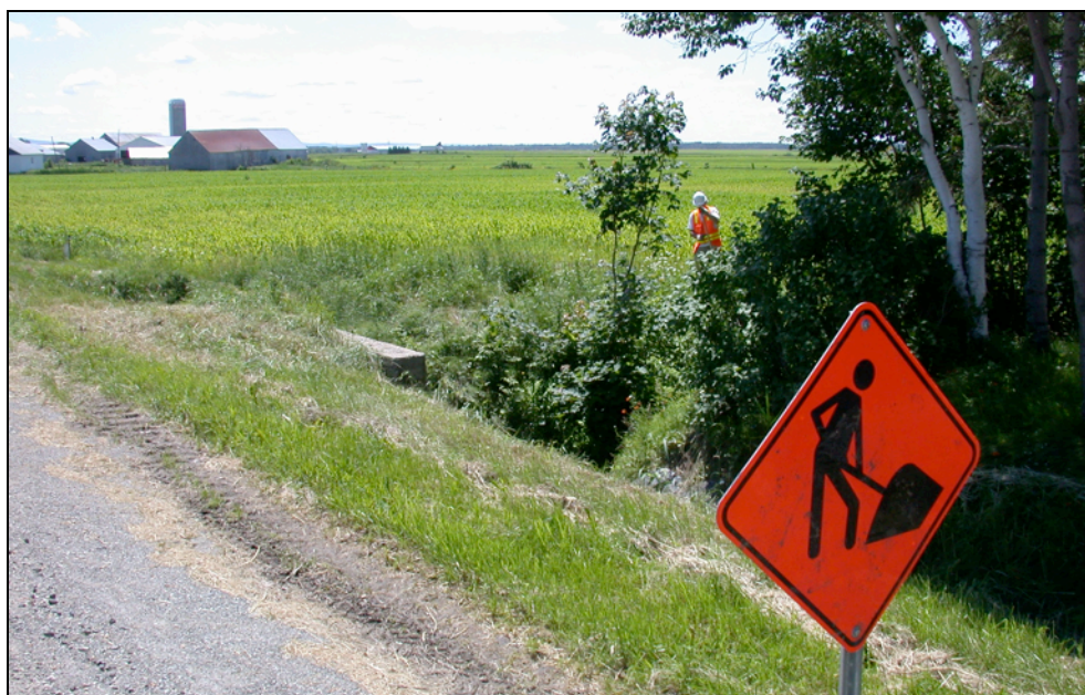
Photo 8 Projet n° 154-07-0141, secteur 5, ponceaux n° 134 010 (sud-est)
