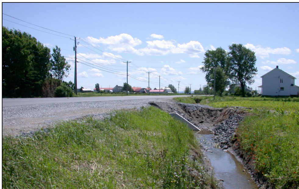
Photo 7 Projet n° 154-07-0141, secteur 4, ponceaux n° 134 006 (sud-est)
