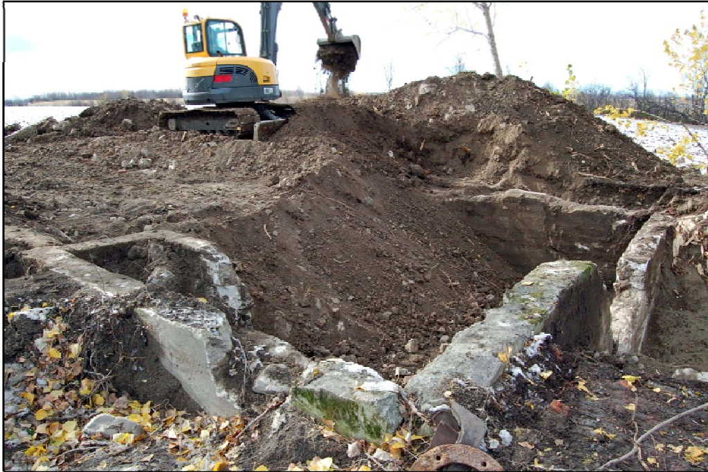
Photo 13 Site BhFI-26, vue du vestige V12 en cours de dégagement, vers l'est (PATR08N11-012)
