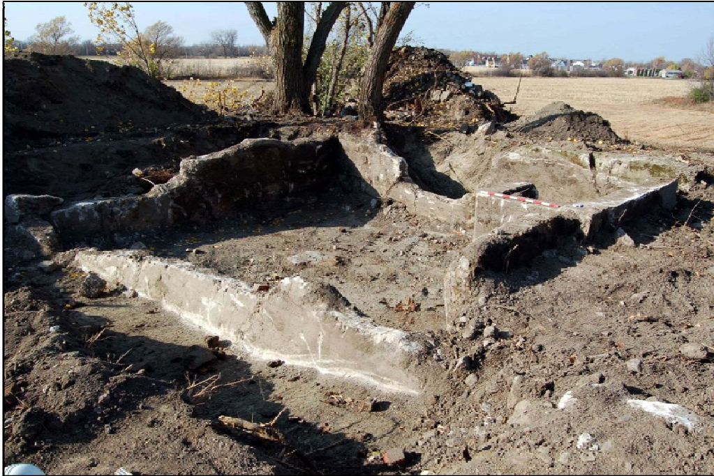
Photo 17 Site BhFI-26, vue de la fondation de béton, vers le nord-ouest (PATR08N11-040).
