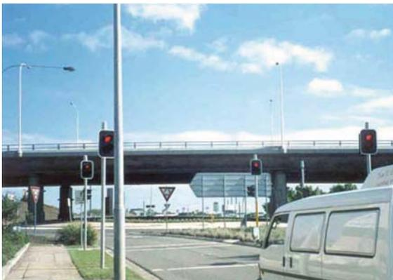
Le feu pour piétons à ce giratoire à Sidney, en Australie, faisant partie d'un échangeur, a été aménagé l'été de l'an 2000 en raison des quelques centaines de piétons qui traversent cet endroit en provenance de la station de train à proximité.
